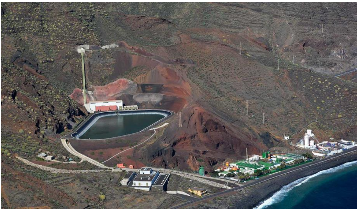
Figura 10. Depósito inferior, edificio de subestación y bombeo y central térmica Llanos Blancos. Fuente: Google
