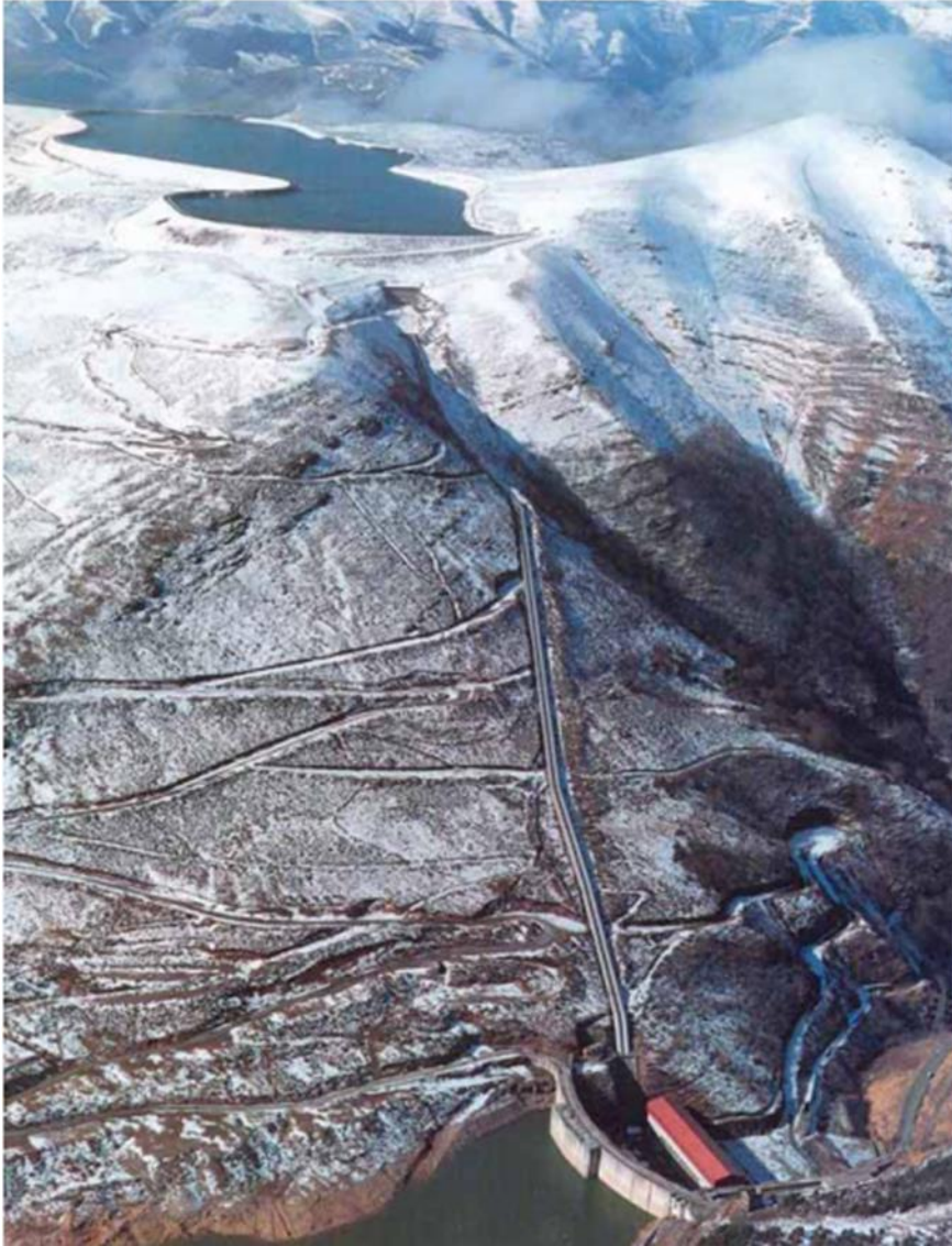
Figura 03. Transformación de Alsa en la central de Aguayo (400 MW). Fuente: Google.
