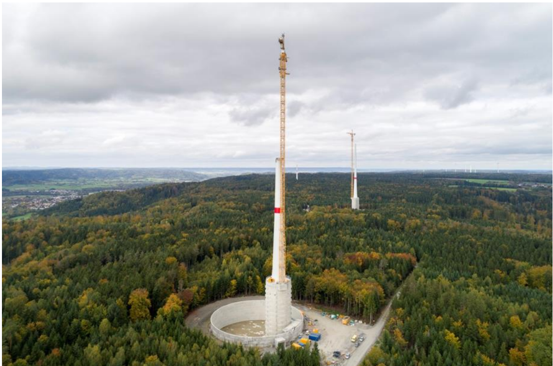
Figura 15. Proceso constructivo torre híbrida – depósitos superiores. Fuente: Max Bögl.
