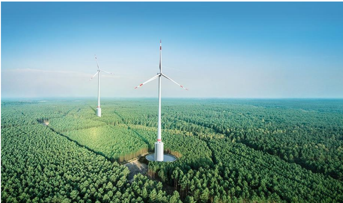
Figura 18. Parque eólico Naturstromspeicher. Fuente: Max Bögl.
