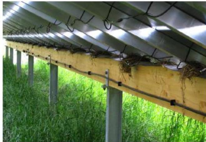
*Figura 6-1 Muestra de soportes de módulos fotovoltaicos que sirven para anidación de aves [15].*
