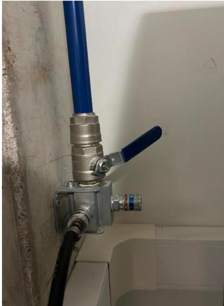
Válvula del aire comprimido.
