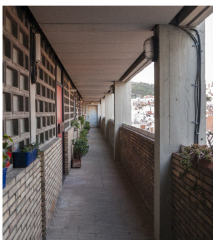
Corredor de acceso a viviendas en torre de la manzana Escorial.
