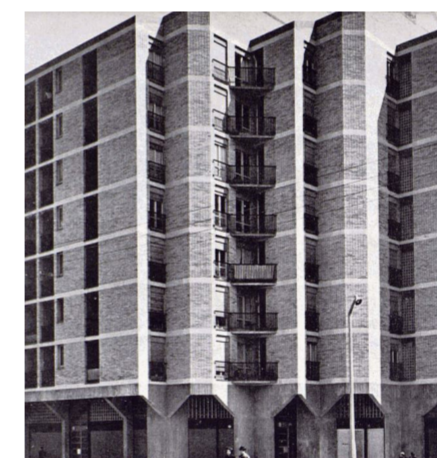
Esquina del edificio Navas de Tolosa.
