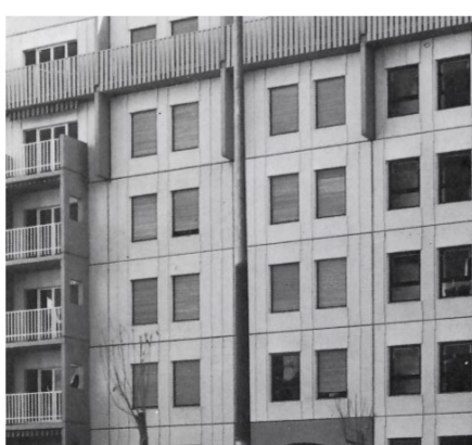
Alzado de placas prefabricadas de Vall-Roig.
