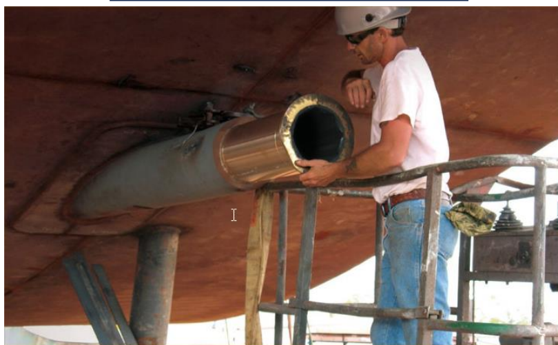
Ilustración 5-7.-Instalación de la bocina en el buque. Fuente: Johnson Cutless
