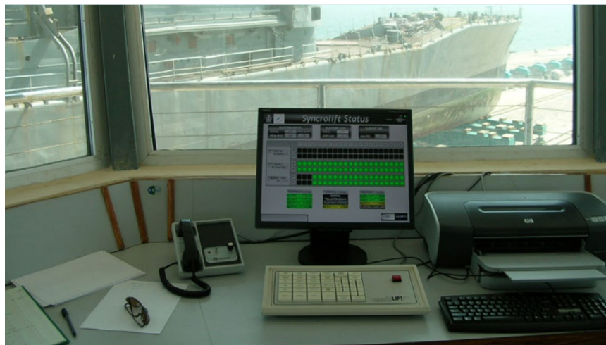
([17], s.f.) ILUSTRACIÓN 27 PUESTO DE MANDO DE UN SYNCROLIFT
