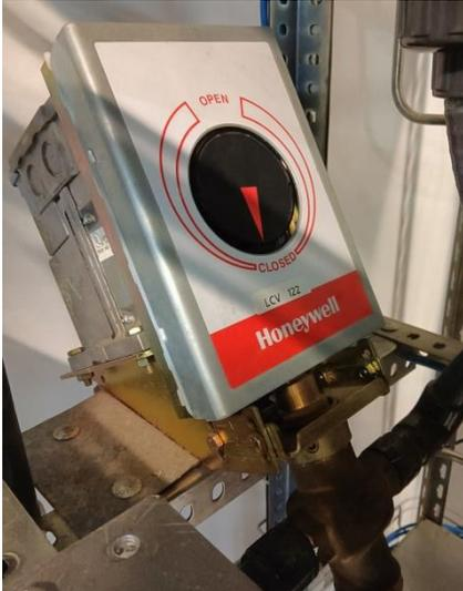
Ilustración 65 Válvula motorizada
