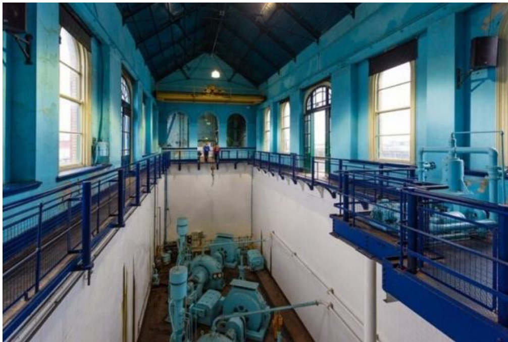
Ilustración 26. Casa de bombas del dique seco de Belfast, Irlanda.
