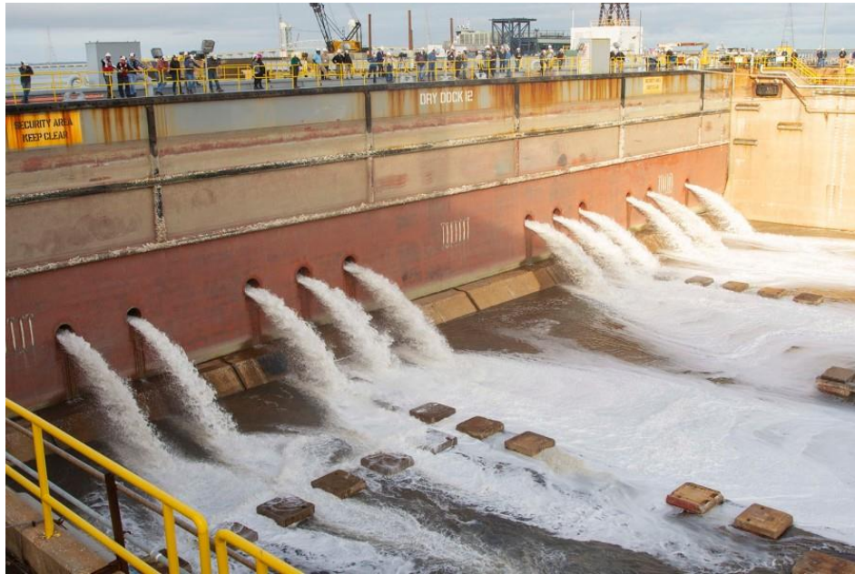
Ilustración 23. Compuertas de inundación
