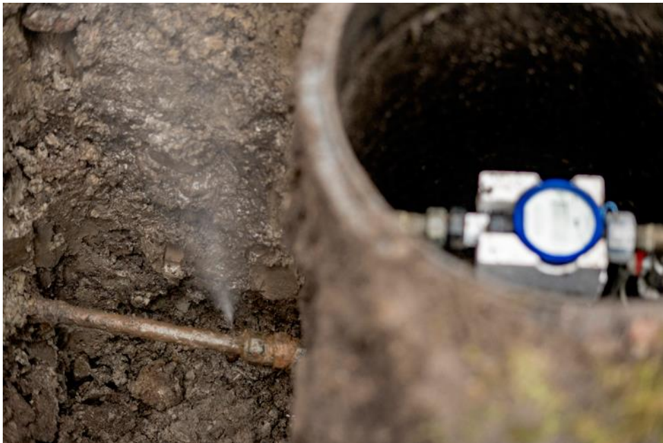
Ilustración 30. Detección de fugas en tuberías mediante pruebas acústicas
