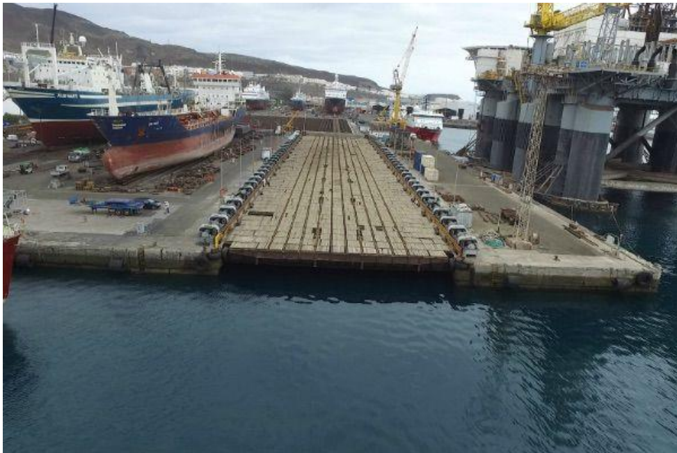
Ilustración 8. Synchrolift del astillero Astican, en las Palmas, España.
