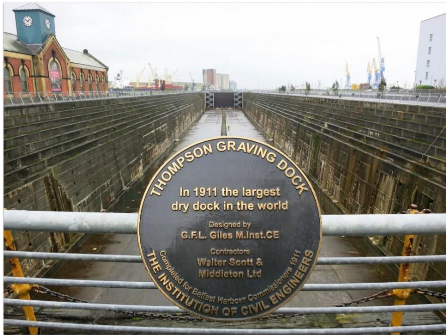
Ilustración 15. Dique seco donde se construyó el Titanic, en Belfast, Irlanda
