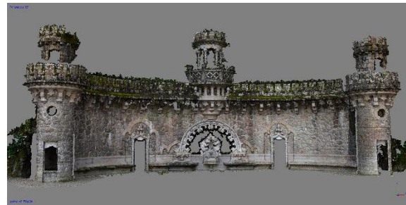
Figura 3. La Quinta da Regaleira a Sintra: il Portal dos Guardiães, nuvola dei punti. (rilievo G. P. Lento)
