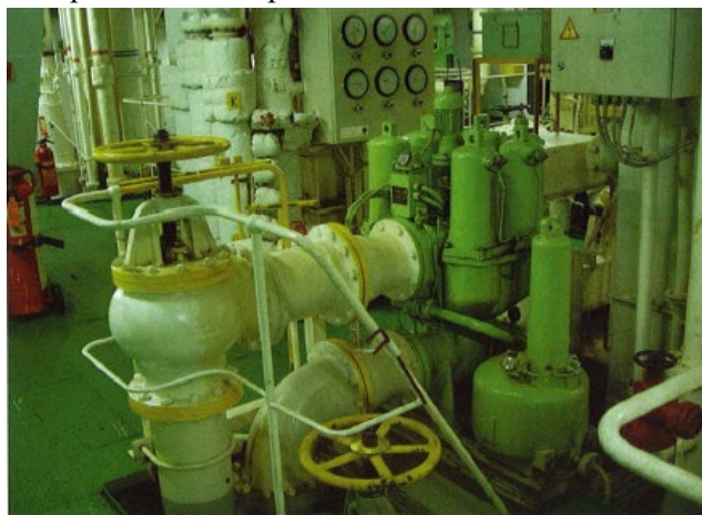
Ilustración 17. Filtro de aceite de motor Diesel lento de dos tiempos. (Universidad de Cádiz)
