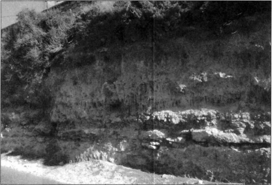
LAMINA III. Estructuras erosivas del tipo alveolar y en candelera.
