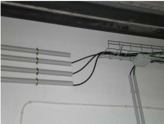
Figura 8. Ejemplo de canalización de enlace
