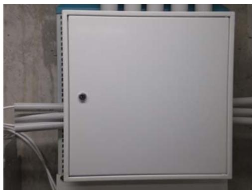
Figura 11. Registro secundario de una planta de 2 viviendas
