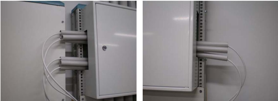
Figura 15. Ejemplos de canalizaciones secundarias
