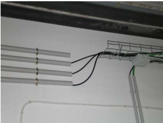
Figura 8. Ejemplo de canalización de enlace
