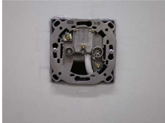
Figura 18. Detalle de registro de Toma Y Toma de Usuario
