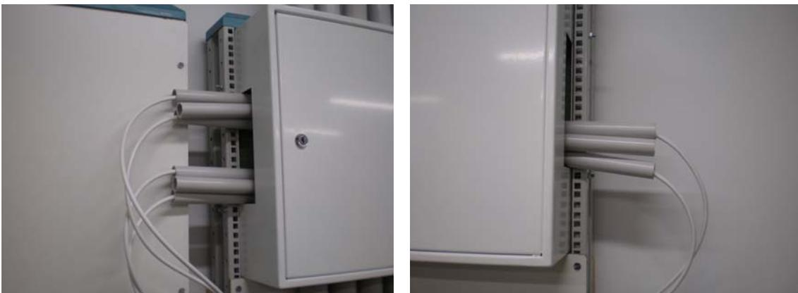
Figura 15. Ejemplos de canalizaciones secundarias
