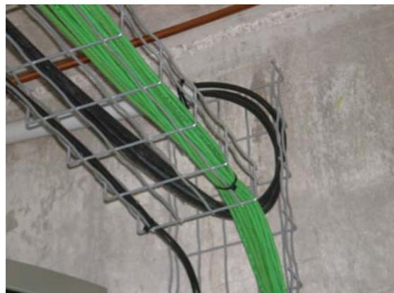
Figura 9. Ejemplo de canalización de enlace
