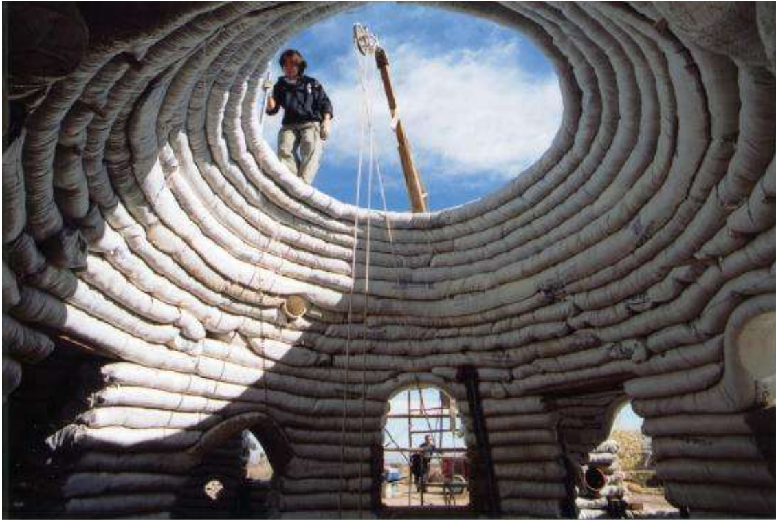
Figura 40: Fotografía de la construcción de un refugio con la técnica de superadobe. Disponible en: https://www.calearth.org/intro-superadobe
