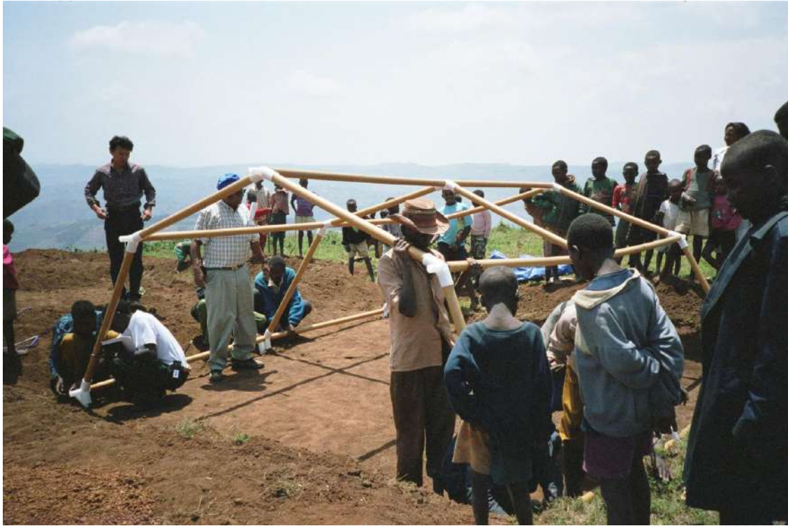
Figura 100: Imagen montaje estructura de tubos de cartón para refugio en Ruanda. Autor: Shigeru Ban Architects. Disponible en: https://www.plataformaarquitectura.cl/cl/02-346388/la-obra-social-y-caritativa-del-premio-pritzker-2014-shigeru-ban
