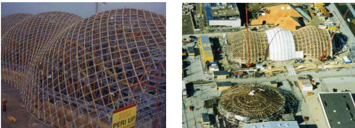
Figura 90: Imágenes durante el proceso constructivo. Disponible en: http://www.shigerubanarchitects.com/works/2000_japan-pavilion-hannover-expo/index.html
