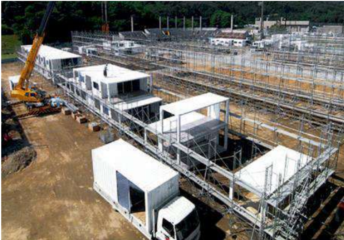
Figura 17: Imagen del proceso de colocación de los contenedores. Disponible en: https://arquitecturaviva.com/obras/viviendas-temporales-container
