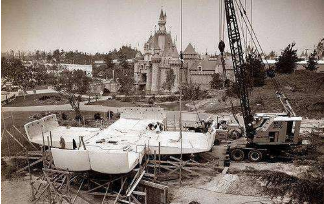
Figura 18: Fotografía del proceso de construcción de "La casa del futuro". Disponible en: http://www.bubblemania.fr/es/maison-du-futur-1957-1967-disneyland/
