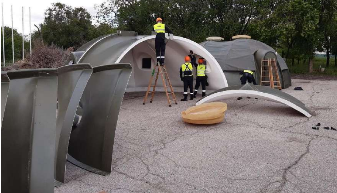
Figura 23: Operarios montando uno de los módulos con capacidad para 6 personas, de un Campamento de Damnificados (CDAM). Disponible en: https://www.defensa.gob.es/ume/noticias/2021/05/Noticias/cdam-copex21.html
