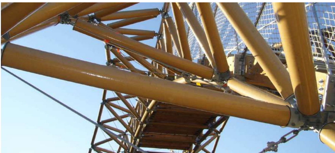
Figura 96: Imagen detalle de las uniones de los tubos de la estructura. Disponible en: https://oamarchitecture.wordpress.com/2013/11/26/paper-bridge-shigeru-ban/
