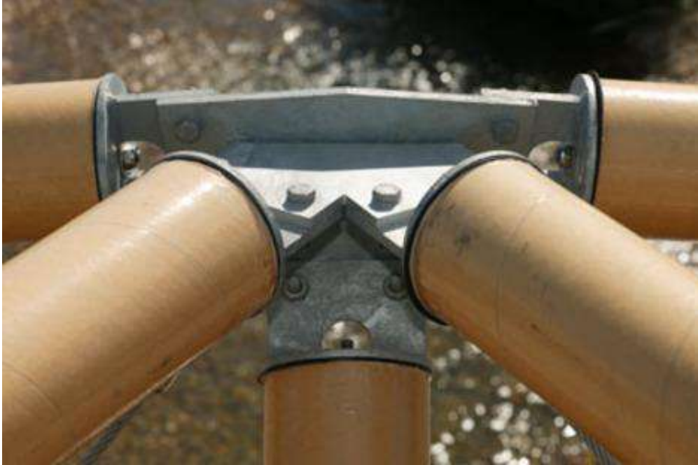
Figura 97: Detalle juntas de acero para la unión de los tubos. Disponible en: https://www.floornature.com/architectural-solutions/pont-du-gardas-little-brother-cardboard-tube-bridge-shigeru-13405/
