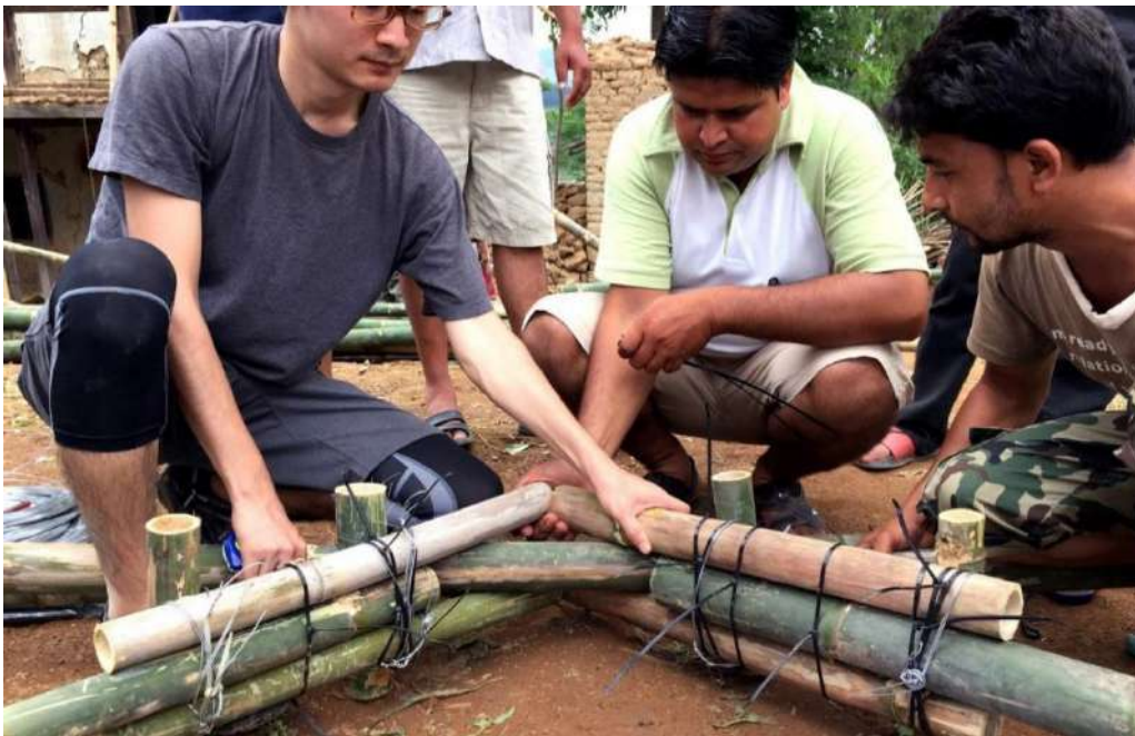
Figura 46: Explicación de técnicas de ensamblaje de bambú a ciudadanos locales. Autor: Charles Lai, Takehiko Suzuki. Disponible en: https://www.plataformaarquitectura.cl/cl/939306/5-materiales-alternativos-para-construir-refugios-de-emergencia
