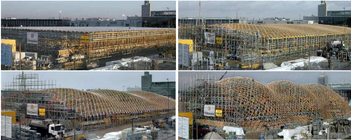
Figura 89: Imágenes levantamiento de la rejilla de tubos de cartón. Disponible en: https://arquitecturaviva.com/obras/pabellon-de-japon-en-expo-2000
