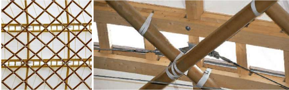
Figuras 91: Imagen del entramado de cubierta y detalle de la union entre estructura y cubierta, pabellón japonés Expo 2000. Disponible en: https://arquitecturaviva.com/obras/pabellon-de-japon-en-expo-2000#
