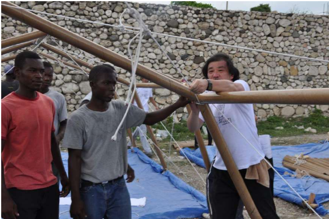
Figura 101: Imagen en la que aparece el propio Shigeru Ban colaborando en la construcción de la estructura del refugio para víctimas del terremoto de Haití en 2010. Disponible en: https://www.plataformaarquitectura.cl/cl/02-346388/la-obra-social-y-caritativa-del-premio-pritzker-2014-shigeru-ban
