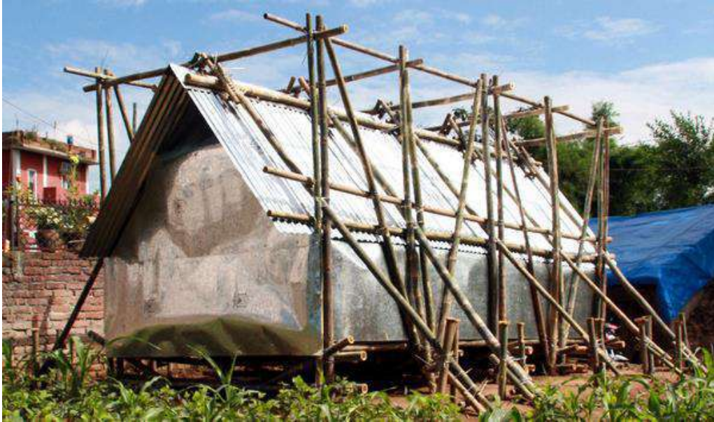
Figura 45: Refugio con estructura de bambú, material que se puede encontrar a escala local en muchas partes del mundo. Autor: Charles Lai, Takehiko Suzuki. Disponible en: https://www.plataformaarquitectura.cl/cl/939306/5-materiales-alternativos-para-construir-refugios-de-emergencia
