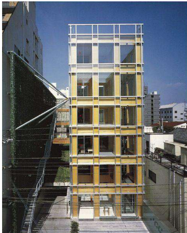
Figura 71: Fotografía de la fachada principal del GC Osaka Building. Disponible en: http://www.shigerubanarchitects.com/works/2000_gc_osaka_building/index.html
