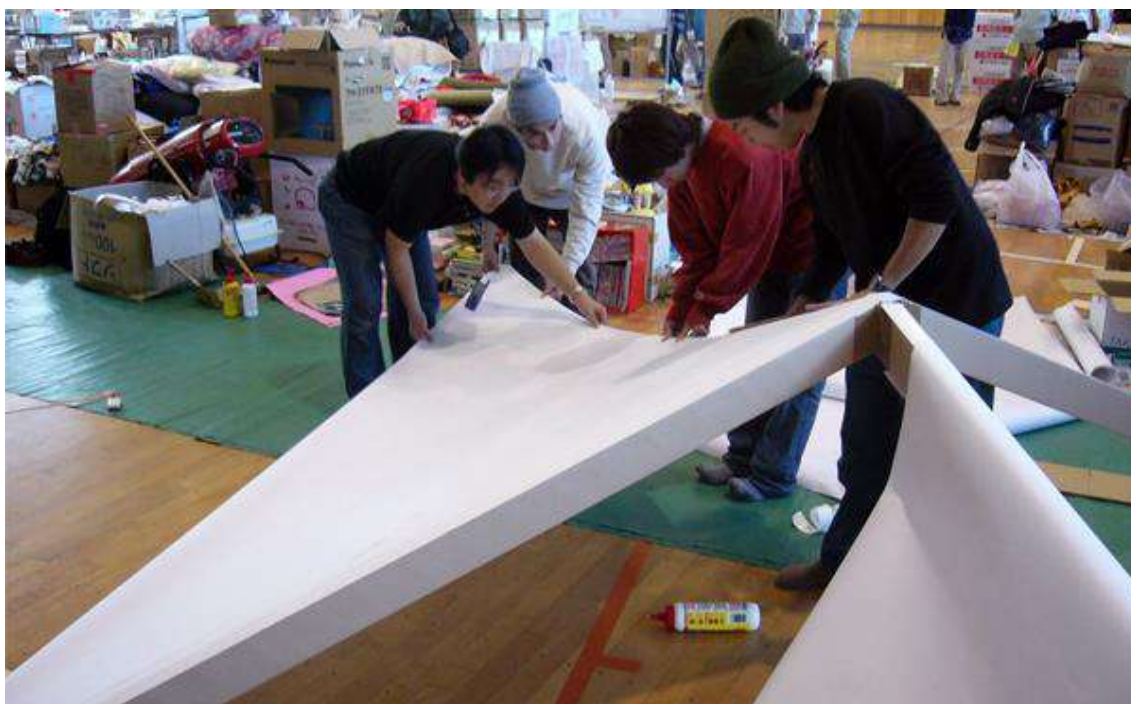
Figura 109: Voluntarios colocando el papel que sirve de cubrición. Disponible en: https://www.experimenta.es/noticias/industrial/shigeru-ban-japon-refugio-terremoto-tsunami-artuitectura-2827/
