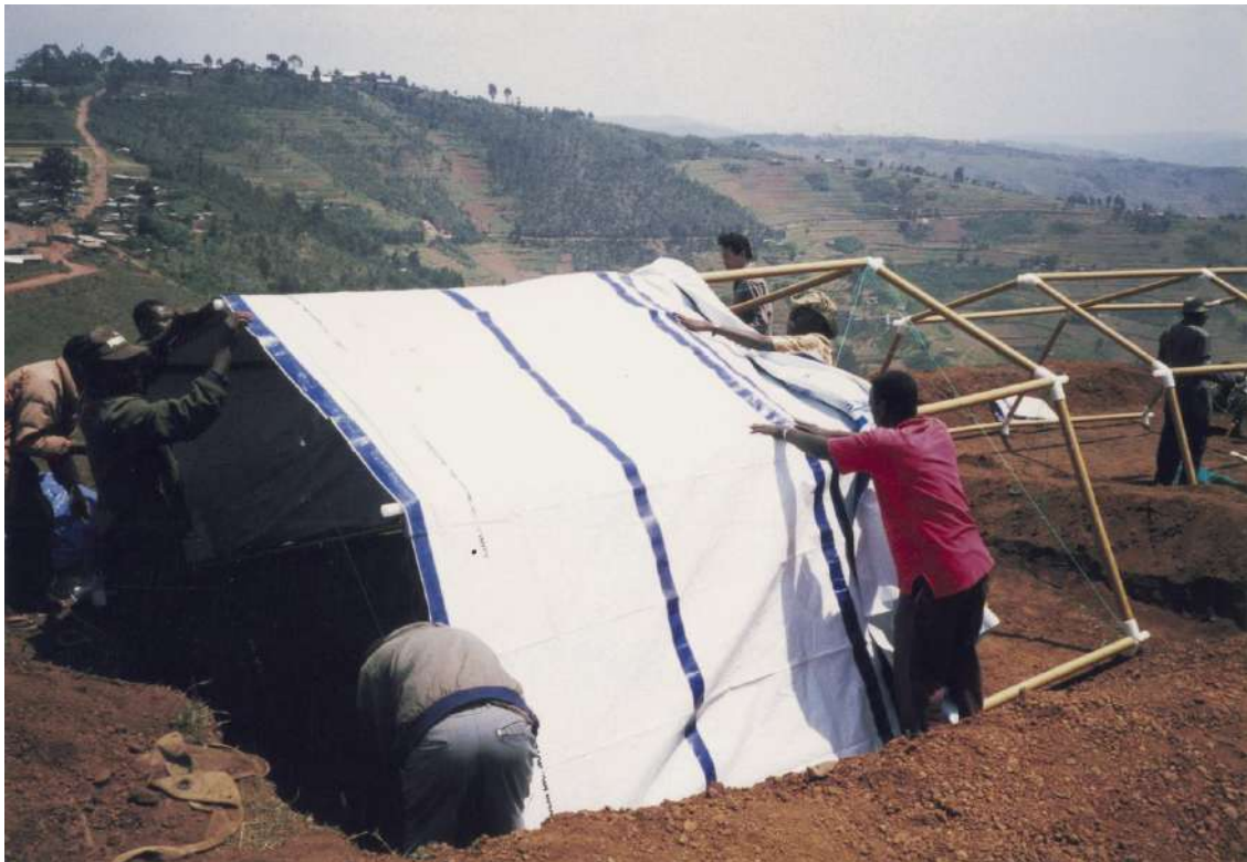
Figura 99: Fotografía colocación lona de cubierta para refugio en Ruanda. Autor: Shigeru Ban Architects. Disponible en: https://www.plataformaarquitectura.cl/cl/02-346388/la-obra-social-y-caritativa-del-premio-pritzker-2014-shigeru-ban
