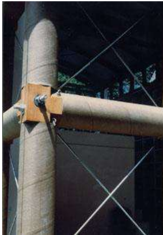
Figura 80: Detalle junta entre tubos de cartón y alambres postensados. Disponible en: http://www.shigerubanarchitects.com/works/1991_library-of-a-poet/index.html
