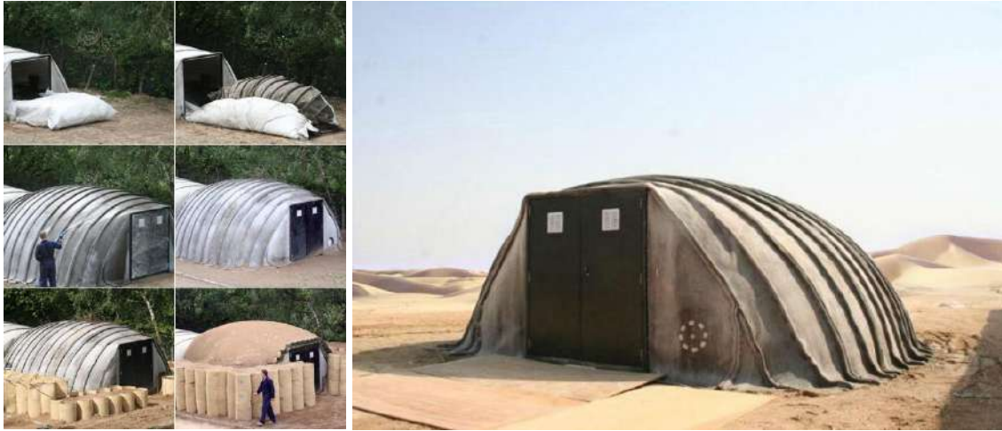
Figura 34: Imagen fases de construcción refugio de lona de hormigón. Disponible en: https://www.concretcanvas.com/es/cc-shelters/
