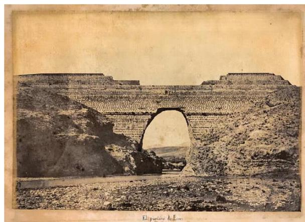
Figura 1.1. Rotura del Pantano de Puentes, 1802
