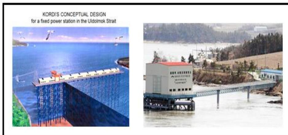
Figura 2.26. Planta de turbinas helicoidales en el estrecho de Uldolmok de Korea. Fuente: *Korean Ocean Research & Development Institute*.
