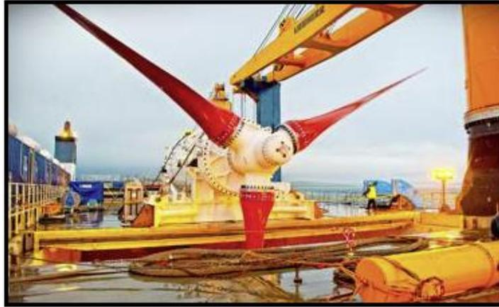
Figura 3.1. Góndola del dispositivo *HS1000* en maniobra de izada. Fuente: *ScottishPower*.
