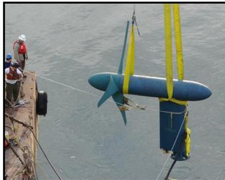
Figura 2.22. Turbina *KHPS*. Fuente: empresa *Verdant Power*.
