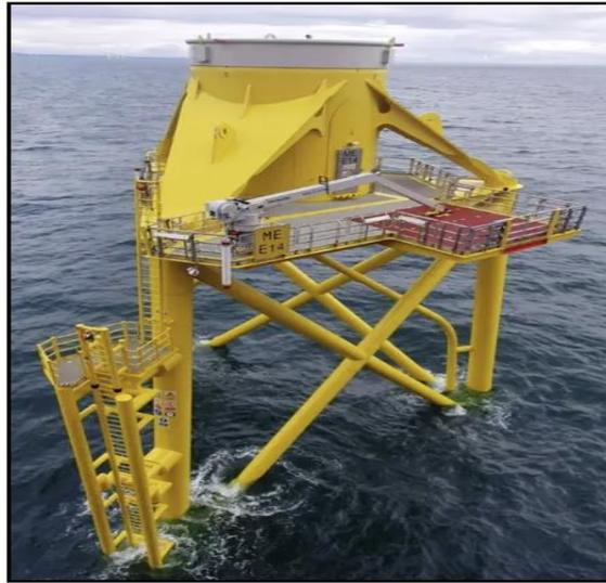
Figura 3.8. Estructura de piles y brazings (refuerzos en cruz) de la plataforma tipo Jacket. Fuente: *DEME Offshore*.
