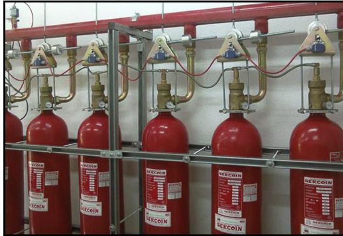
Figura 3.56. Depósitos de CO<sub>2</sub> como agente extintor. Fuente: empresa *SERCOIN*.
