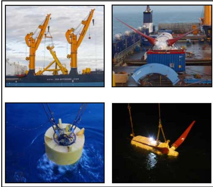
Figura 3.5. Imágenes de la instalación de la turbina HS1000. Fuente: Proyecto HS1000.
