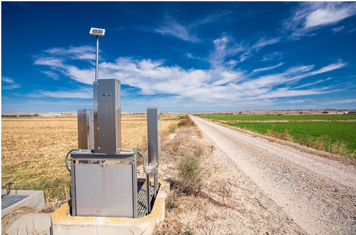
Figura 1. Nodo de 3 compuertas Ziquilink para regar parcelas a la derecha e izquierda del camino.
