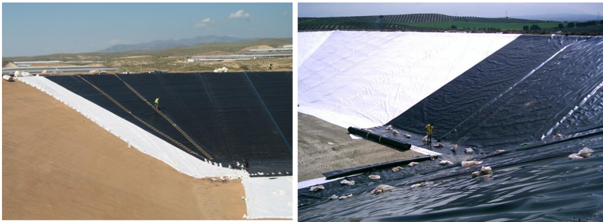
Figuras 1,2 y 3. Detalle de la impermeabilización de embalse de riego. Fotos superiores, compactación, refinado superficie, geotextil de protección y sobre él la geomembrana ALVATECH PEAD, de espesor 1,5 mm ó 2 mm según envergadura del embalse.
