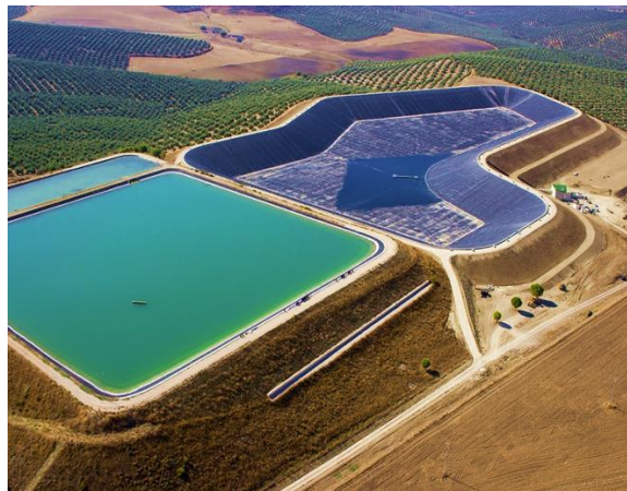
Figuras 1,2 y 3. Detalle de la impermeabilización de embalse de riego. Fotos superiores, compactación, refinado superficie, geotextil de protección y sobre él la geomembrana ALVATECH PEAD, de espesor 1,5 mm ó 2 mm según envergadura del embalse.
