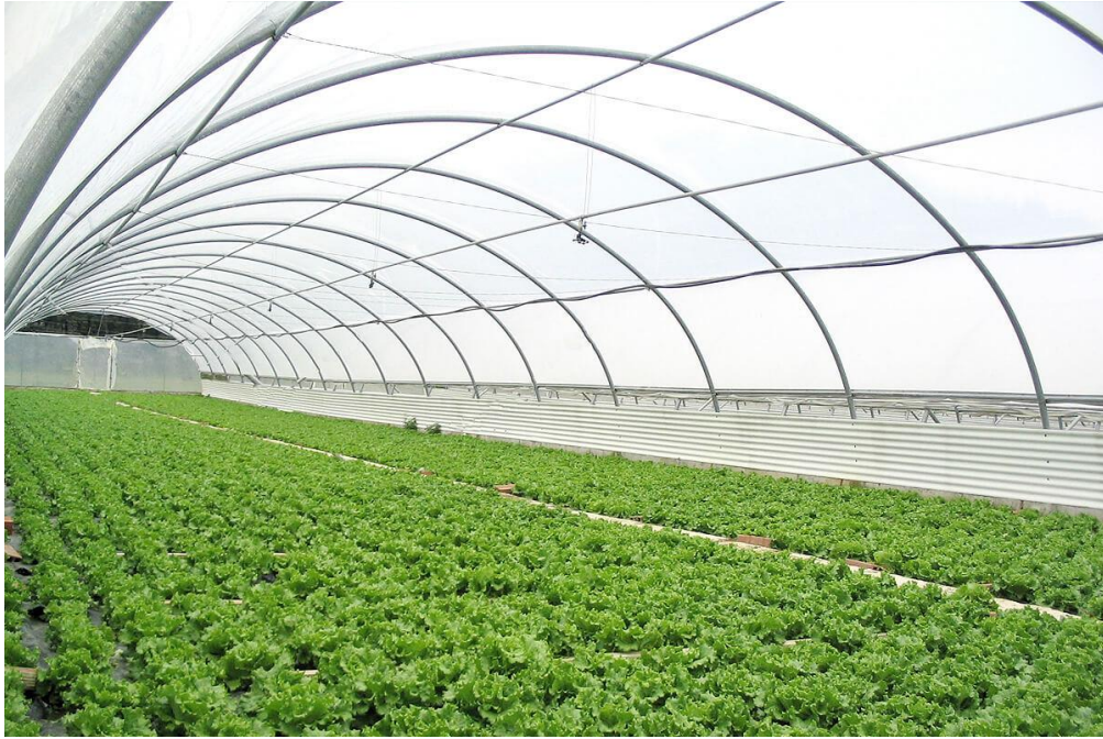
Figura 1. 1. Invernadero tipo Túnel con estructura de acero.
