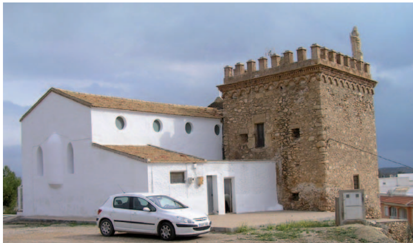
Figura 2. La Torre de Los Caballos antes de la intervención realizada.
