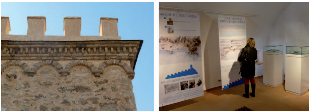
Figura 6. Detalles de las almenas y molduras de ladrillo del alero de cubierta después de la intervención (imagen de la izquierda) y detalle del acondicionamiento interior para el montaje museístico en la planta primera del edificio (imagen de la derecha), con los diferentes paneles expositivos, el material didáctico y la iluminación acorde al nuevo uso de la Torre de los Caballos como espacio expositivo dedicado a “Las torres vigía y la historia del Milagro” .
