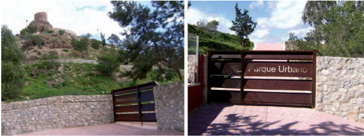
Figura 8. Detalle de las dos puertas de acceso al recinto protegido del Cerro del Molinete.
