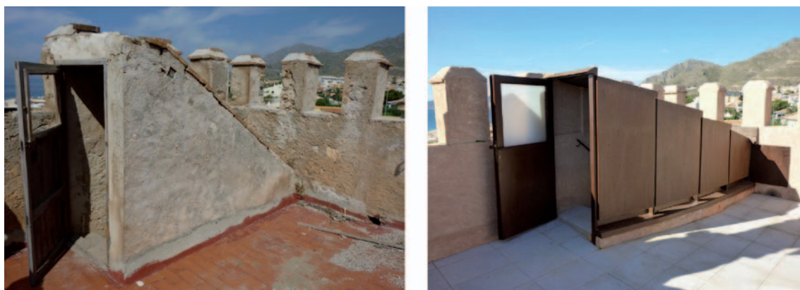
Figura 5. Detalles del casetón de acceso a la cubierta de la Torre de Los Caballos antes de la intervención (imagen de la izquierda) y después (imagen de la derecha) con el nuevo cerramiento de acero corten.
