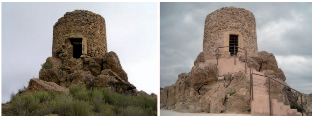
Figura 1. Imágenes de la Torre del Molinete antes (izquierda) y después (derecha) de la intervención.
