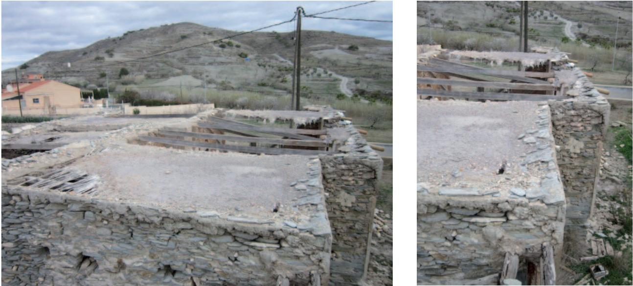
Figura 13 y 14. Cubierta de lágüena.
