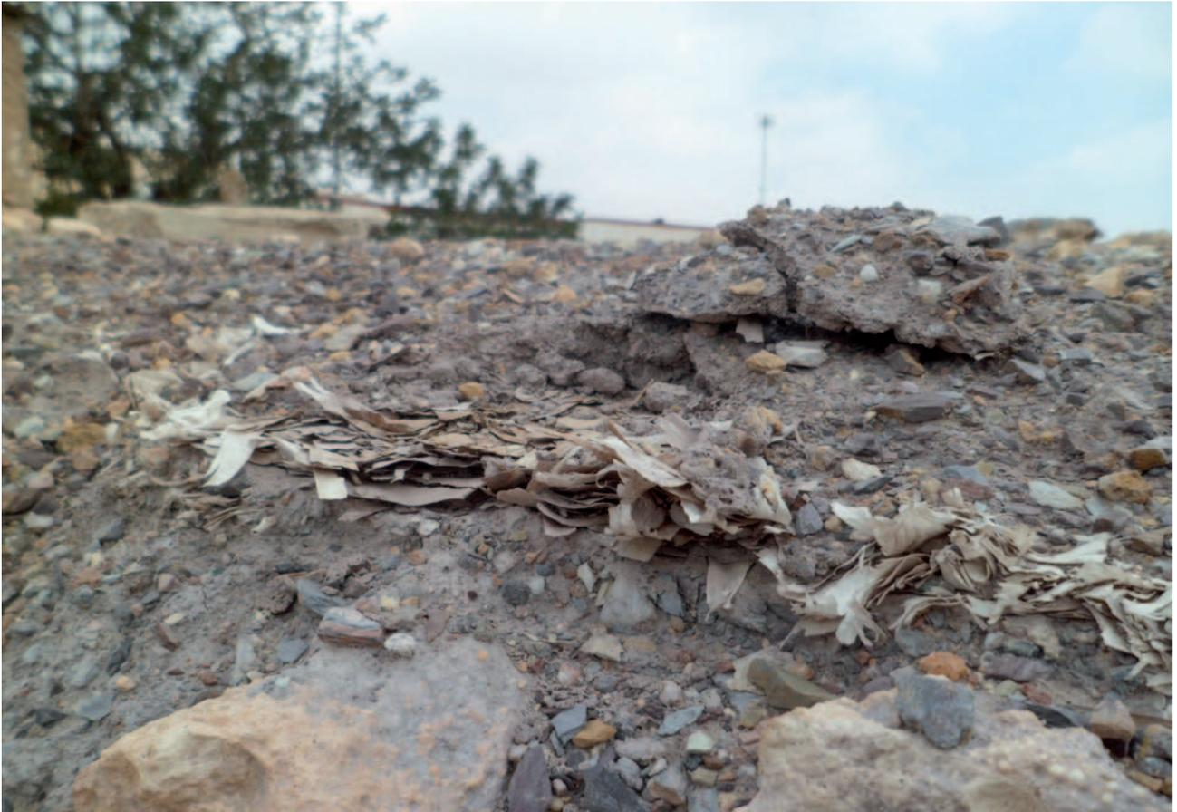
Figura 8. Detalle de las capas de la cubierta: láguaena, algas y piedras.
