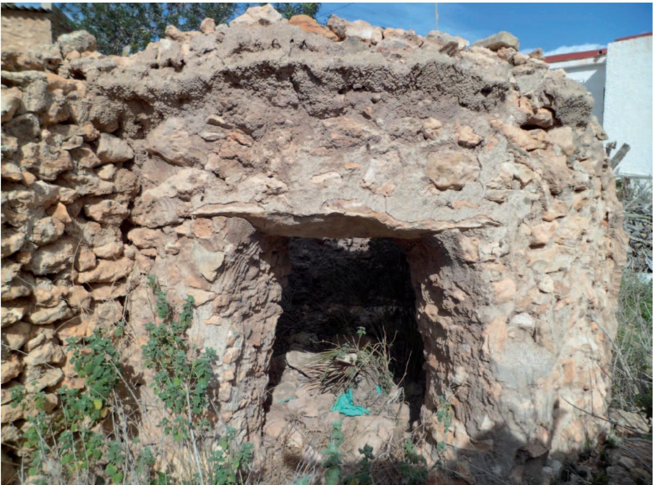
Figura 5. Imagen de una marranera típica. Se aprecia el vano, el espesor del muro, la losa del dintel y parte de una de las paredes del patio.
