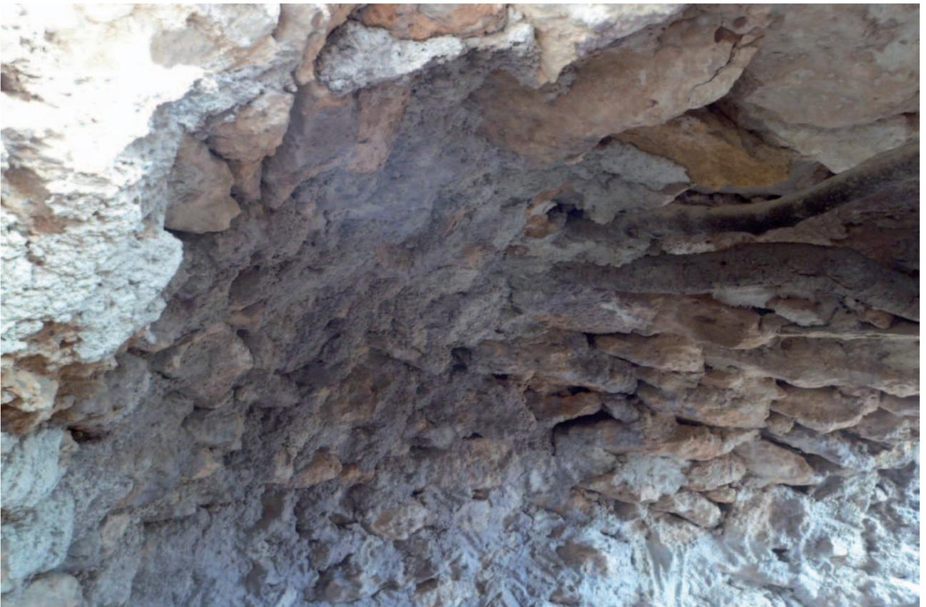
Figura 7. Detalle del interior abovedado y de los troncos y losas de la cubierta.
