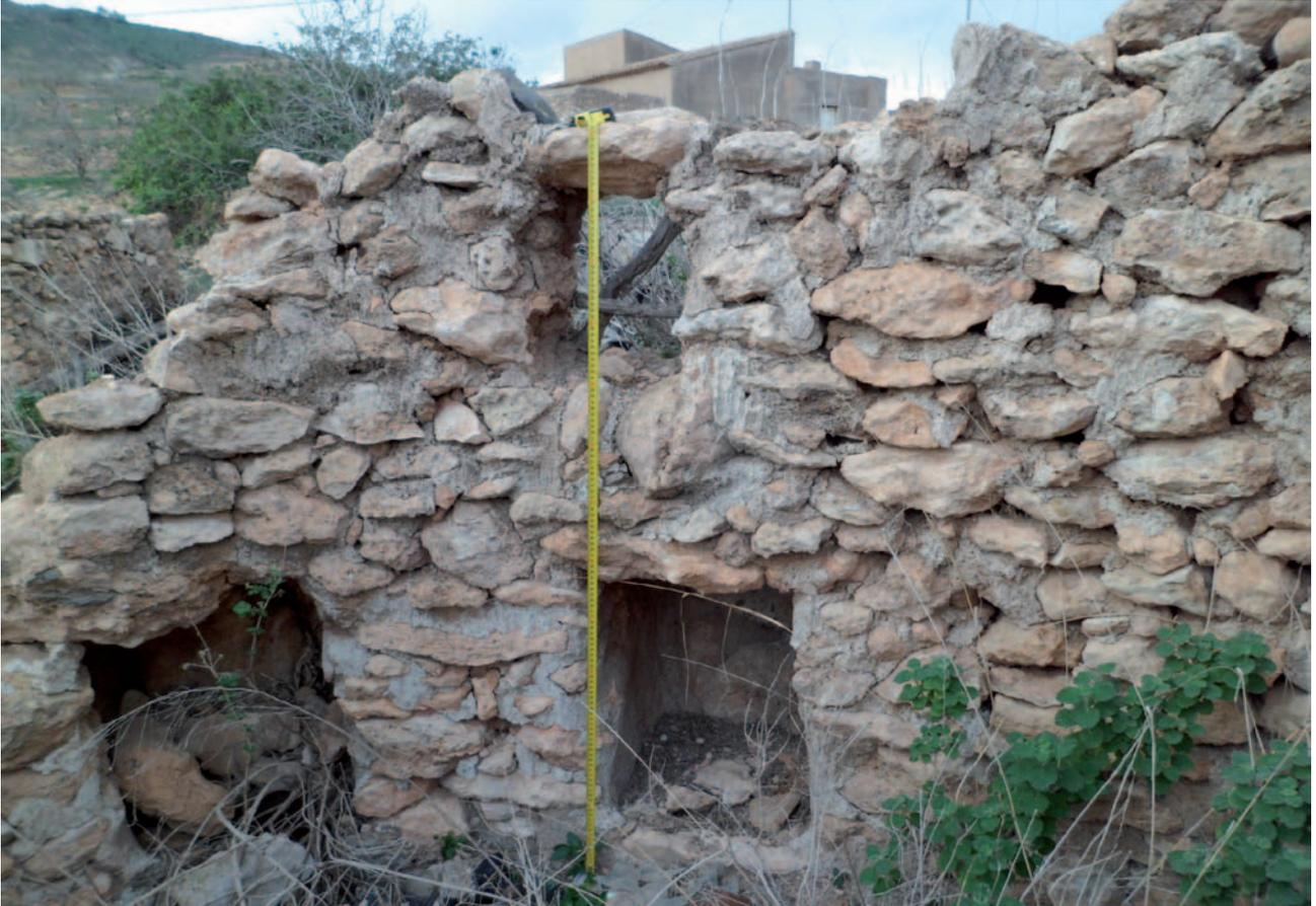
Figura 6. Pared del patio con los pilones de alimentación y vano de observación con celosía de madera.
