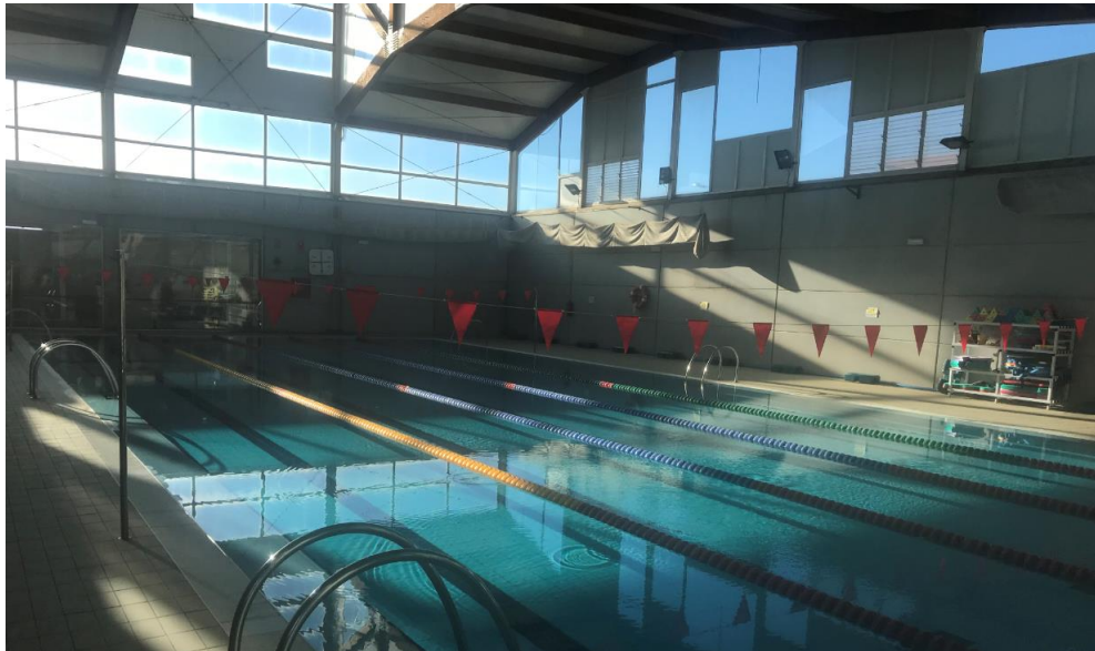
Figura 6. Recinto interior de la piscina.
