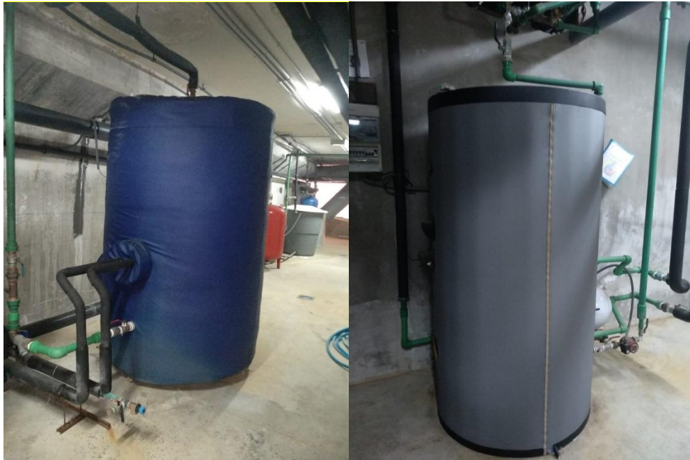
Figura 5. Interacumulador solar (izquierda) e interacumulador de ACS (derecha).
