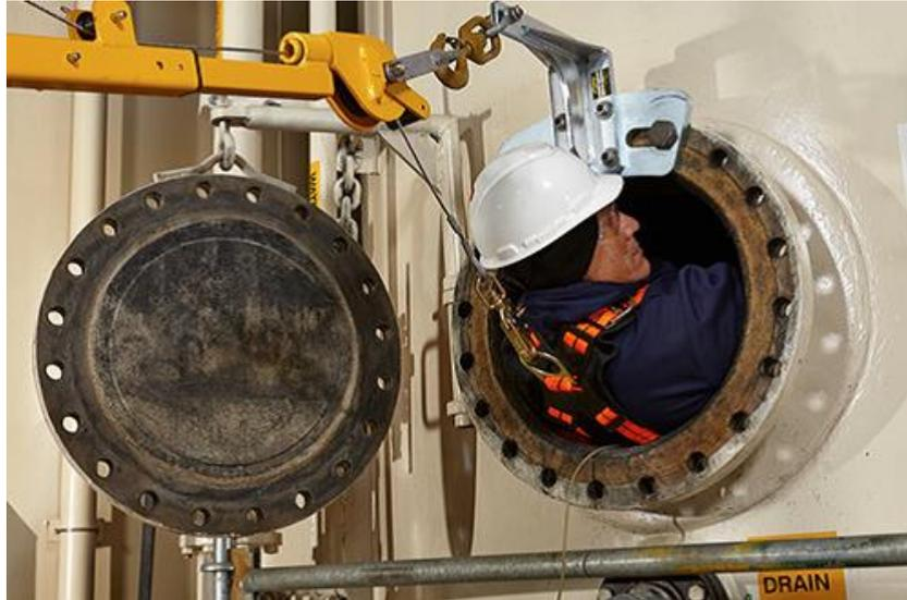
Figura 12. Boca de hombre de un depósito con barra pescante.
