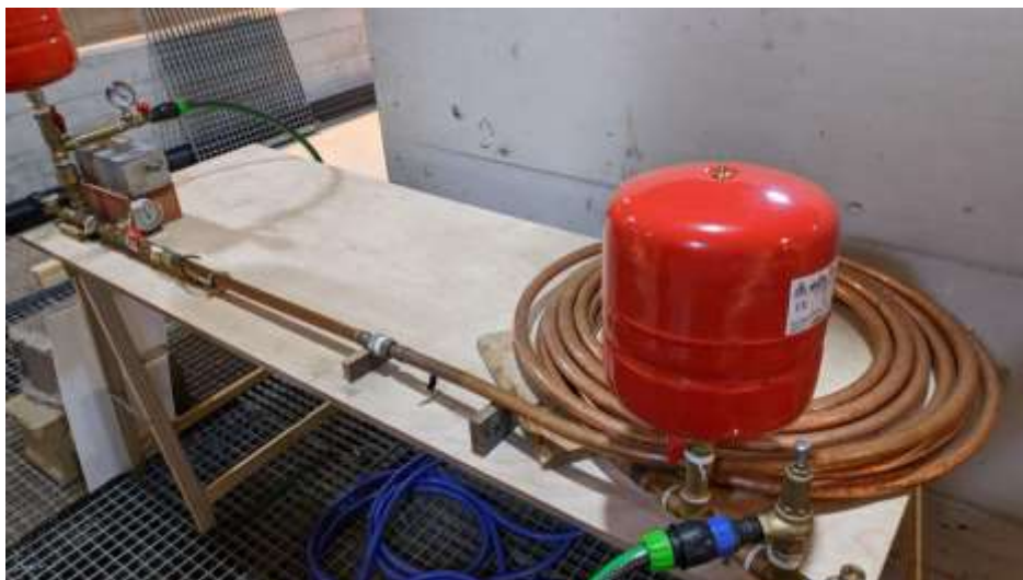
Figura 3.14 – Instalación final de la bomba de ariete
