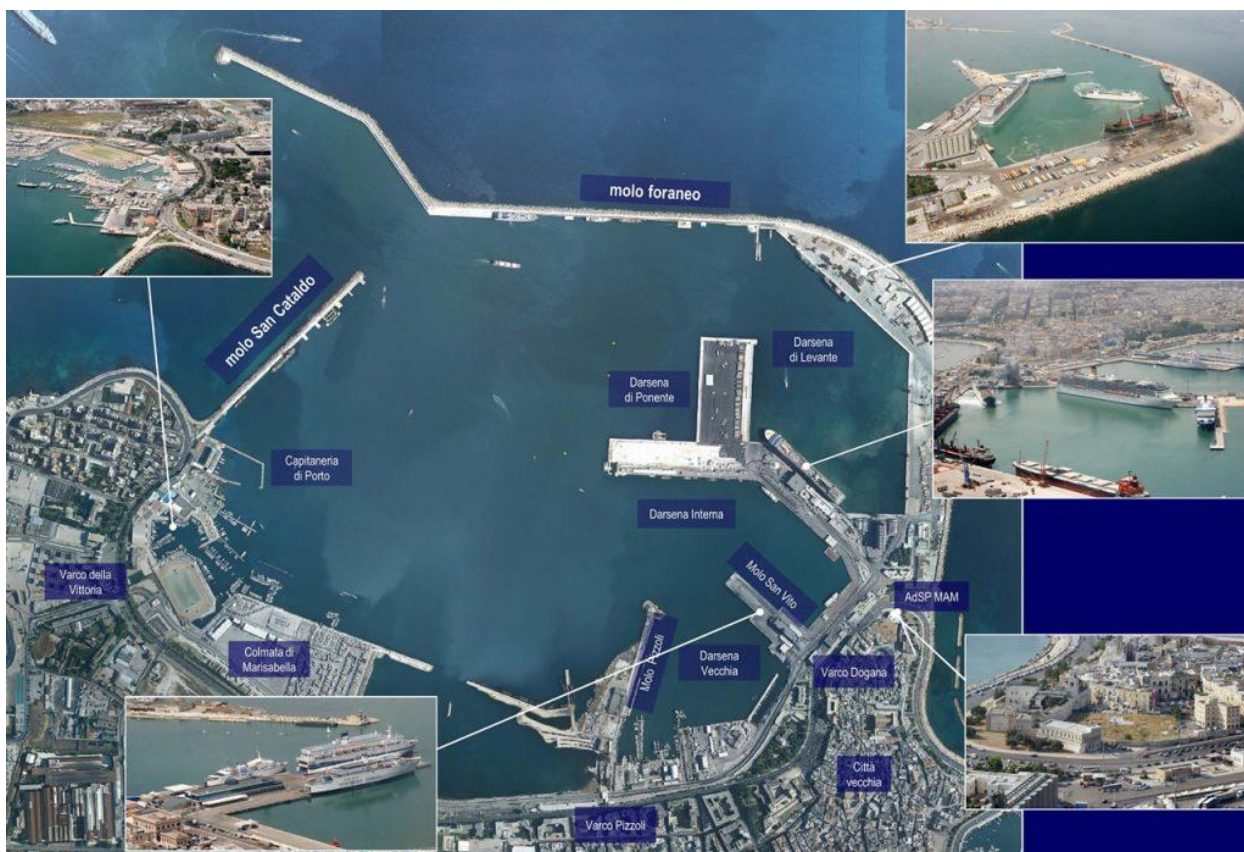
Imagen 31 - Fotografía aérea del puerto de Bari, con el detalle de los nombre de sus estructuras. (Fuente: ADSPMAM 38 ).
