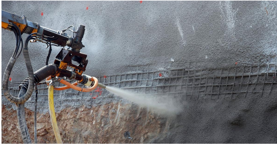
Ilustración 3.5. Técnica Shotcrete de hormigón proyectado.
