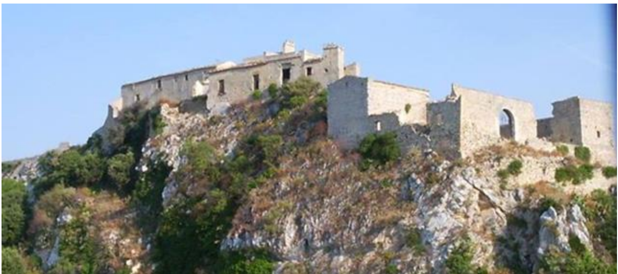
Imagen 19: Frente norte del Castillo tras el deterioro sufrido en 2004.
