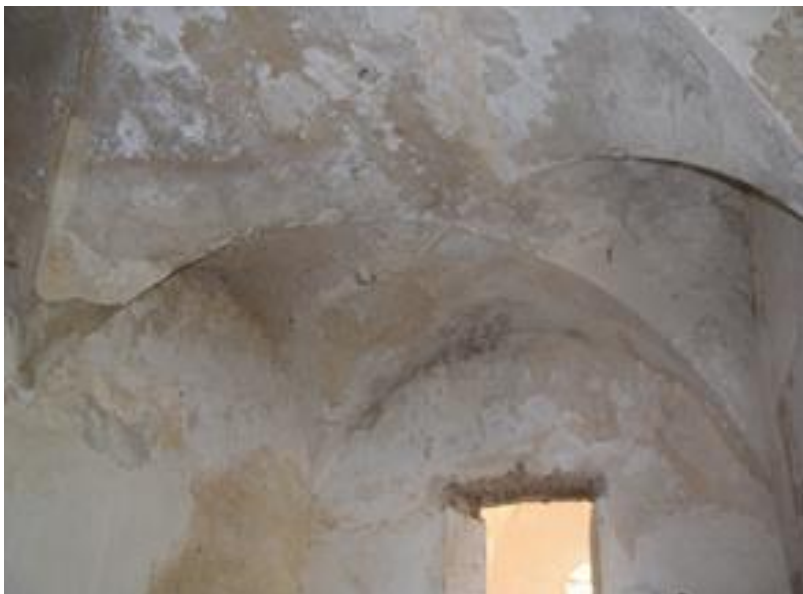
Imagen 11: Habitación cubierta con bóveda de arista
