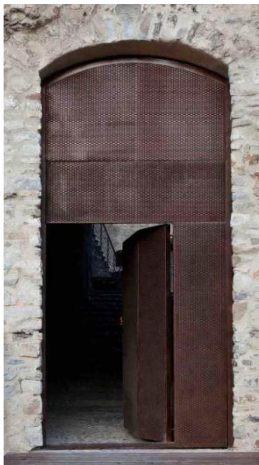
Imagen 63: Puertal de metal. Entrada Castillo de Doria. Proyecto de Andrea Bosio. Restauración del 2015.
