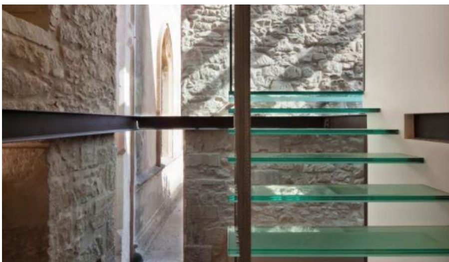
Imagen 76: Escalera interior en vidrio. Restauración de 2012 de “Villa Boscarino”. Arquitecto Salvatore Gozzo.
