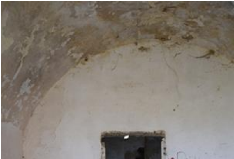
Imagen 10: Habitación cubierta con bóveda de cañón
