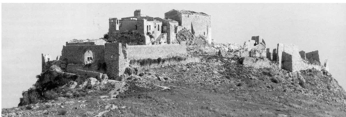
Imagen 8: Foto histórica que muestra cómo el Castillo se construyó siguiendo la inclinación de la roca Fuente: Kalòs : arte in Sicilia. Ha spogli: Il castello di Calatubo: il recupero possibile. Lombardo Vincenzo. Palermo. pp. 14-21, n. 4, 2006
