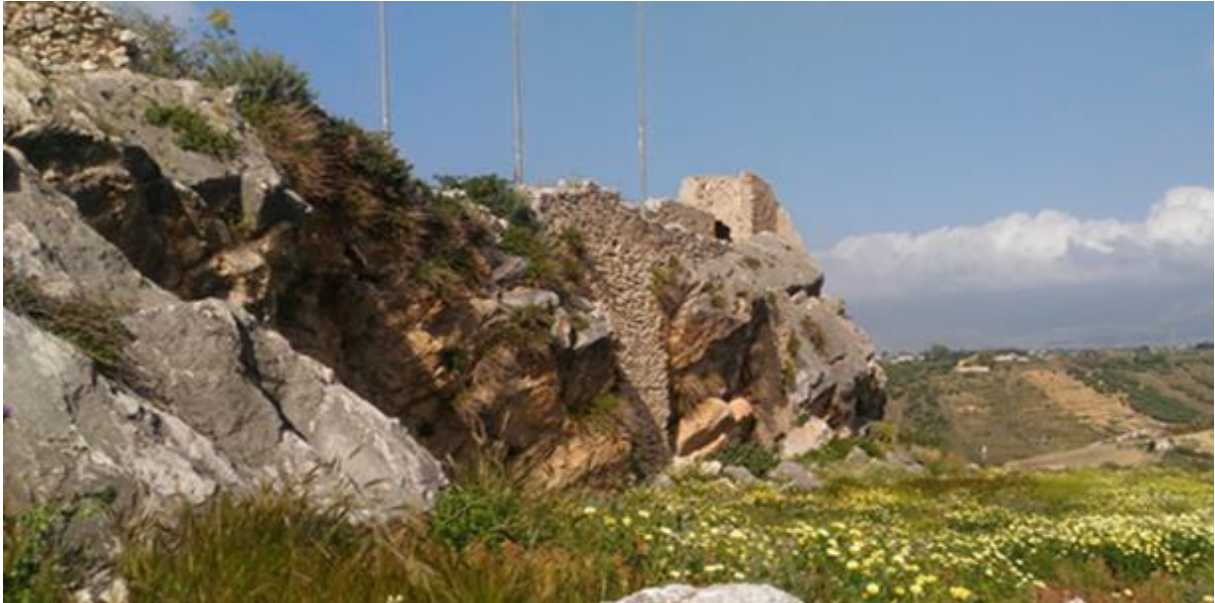
Imagen 25: Muro norte y torre oblonga
