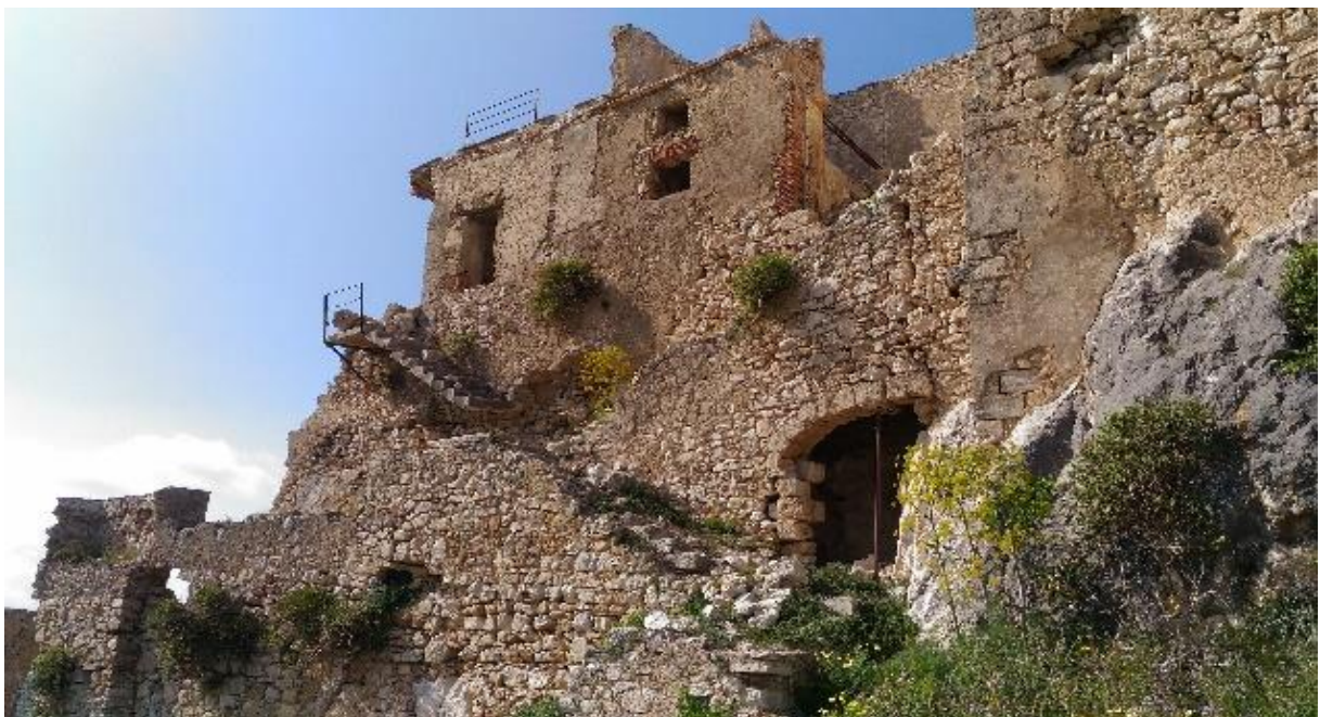
Imagen 15: Escalera en voladizo
