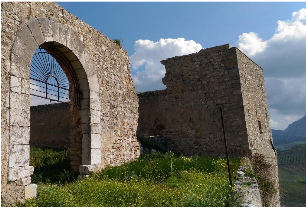
Imagen 33: Puerta de entrada y torre sur
