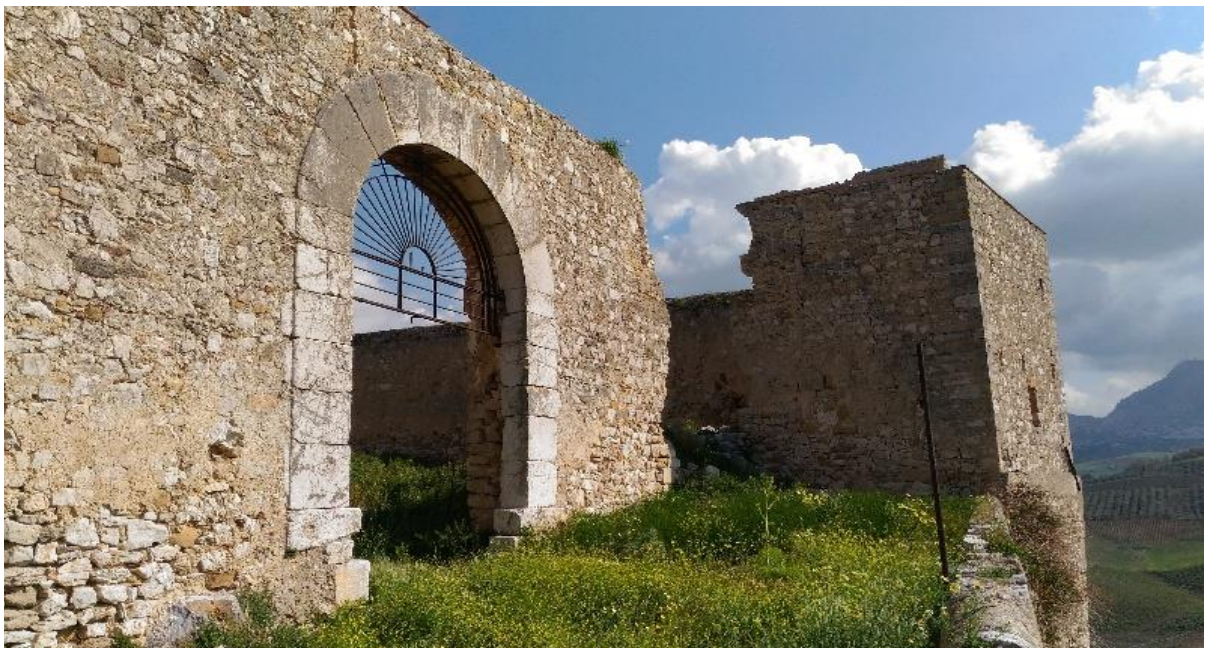
Imagen 12: Puerta de entrada, en el centro de la pared de la fachada
