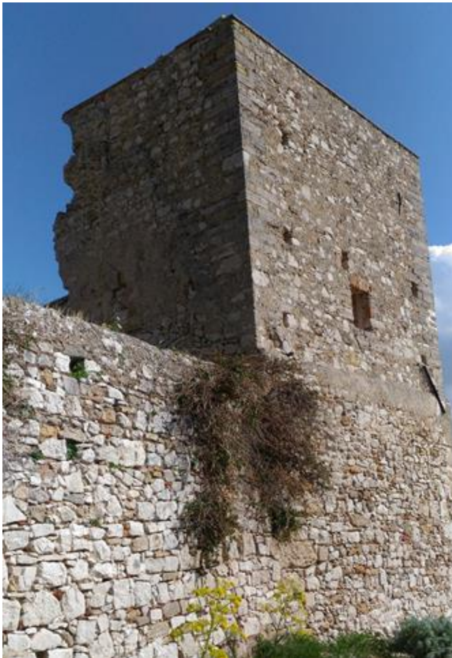
Imagen 40: Torre sur Fuente: Foto Personal.
