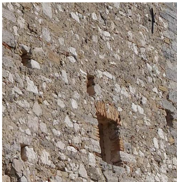
Imagen 28: Muro perimetral de la entrada del Castillo con agujeros defensivos, hecho con piedra caliza solamente esbozada
