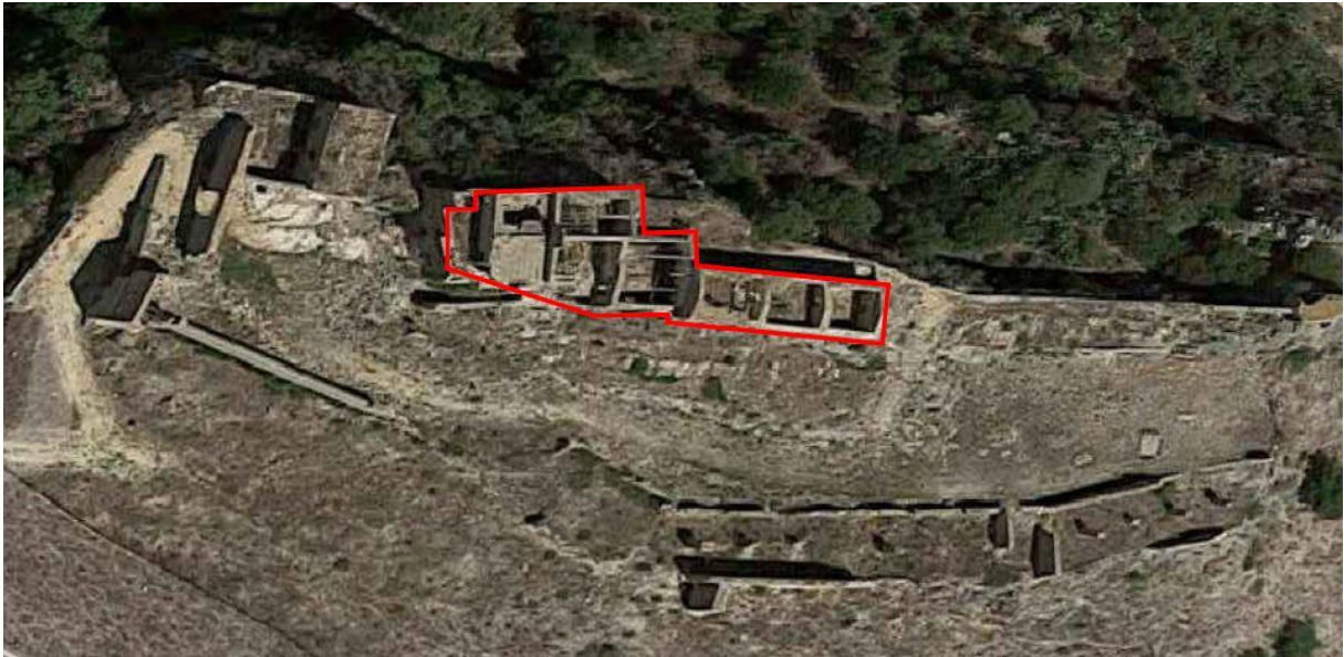
Imagen 71: Indicación de las habitaciones del primer piso de las antiguas residencias del Castillos, actualmente sin cubierta.
