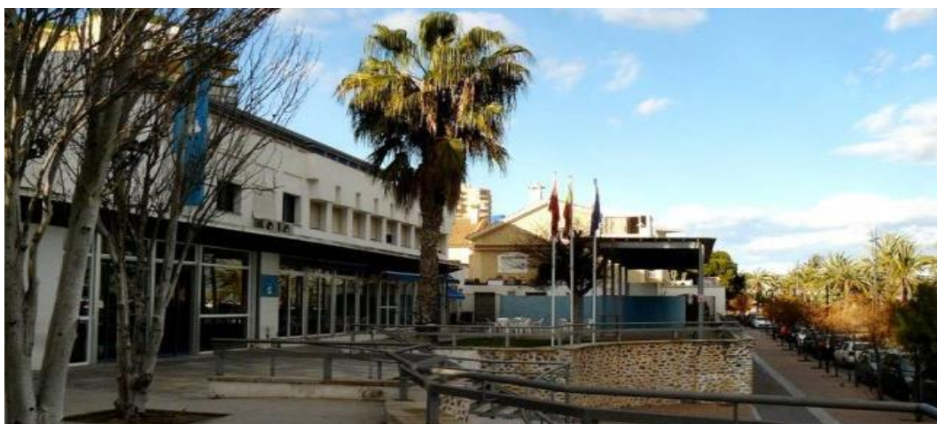
Imagen 4. Antiguo Hospital “Los Arcos” en el Paseo marítimo de Santiago de la Ribera.
