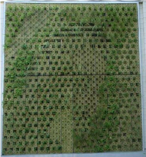
*Ilustración 6: jardín vertical sistema de paneles modulares. Grinea® Vert 75 F.*
