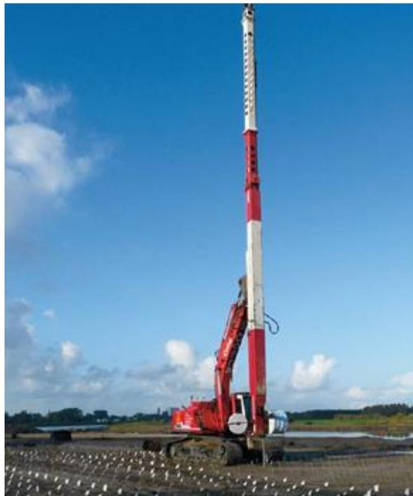
Figura 2.17 Maquinaria usada para la colocación de mechas drenantes
