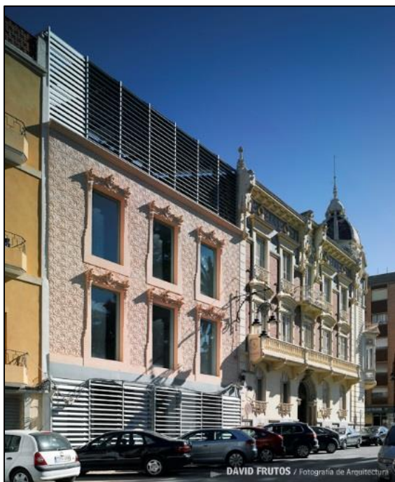
Imagen 15 Fachada exterior Palacio Aguirre
