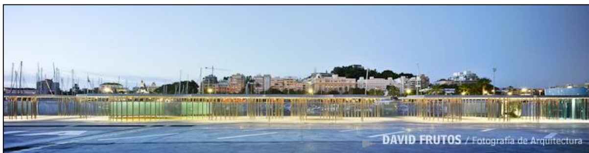
Imagen 8 Panorámica de la nueva terminal de cruceros
