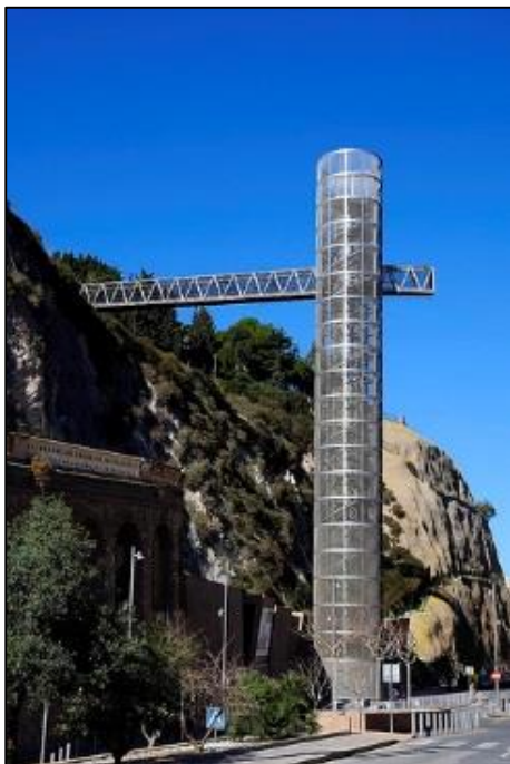
Imagen 13 Vista del Ascensor Panorámico y la Pasarela
