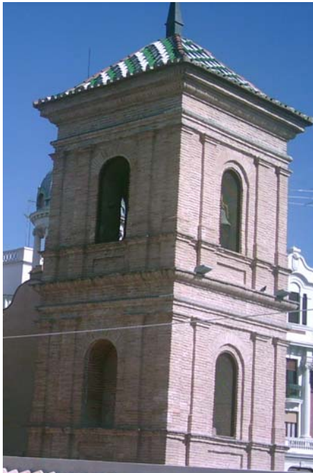
Fig. 17. Ladrillo dispuesto a tizón en las fachadas de las torres.
