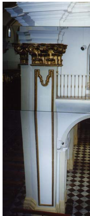
Fig. 30. Pilar de ladrillo de la Iglesia de planta cruciforme. Los ladrillos se traban para un mejor comportamiento frente a los esfuerzos que reciben de las plantas superiores y que conducen al terreno mediante los cimientos.
