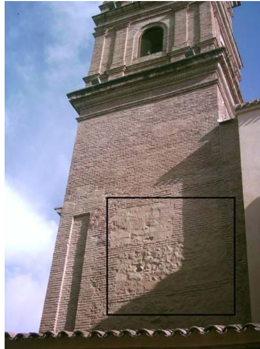
Fig. 22. Aparejo con verdugadas y cadenas de ladrillo.
