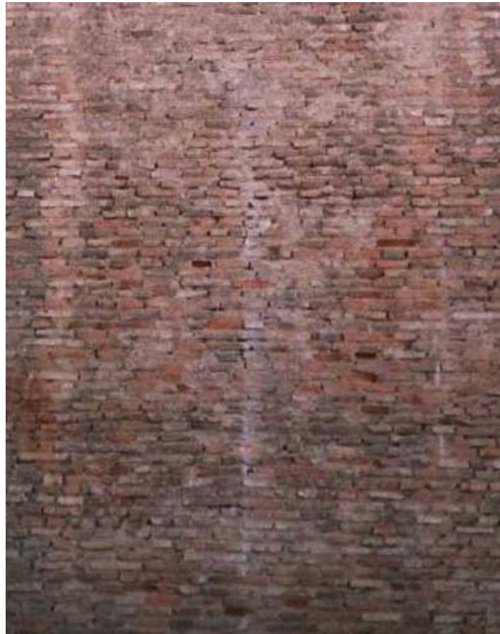
Fig.18. Aparejo belga (apreciable a penas por el deterioro del ladrillo pero se ven hiladas de ladrillo a soga intercaladas con hiladas del mismo a tizón).
