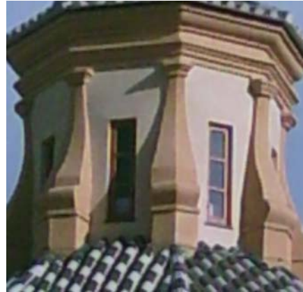
Fig. 26. Linterna de piedra natural revestida con un revoco de mortero de cal.
