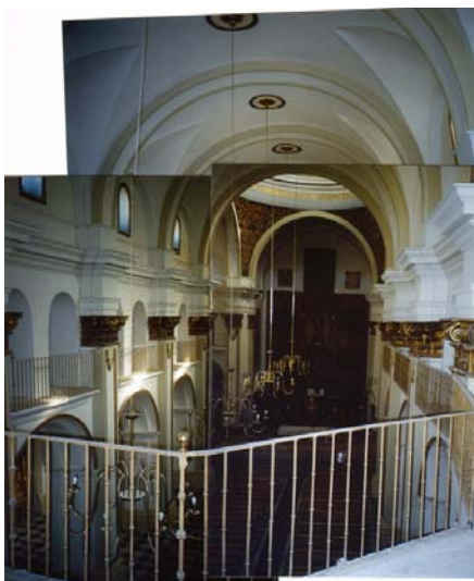
Fig. 37. Bóveda de cañón en la Iglesia conventual de Santo Domingo.
