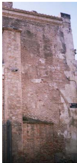
Fig. 25. Encuentro de fachada principal y fachada Norte. Los sillares se encajan en el muro de ladrillo en forma de llaves o perpiñones.
