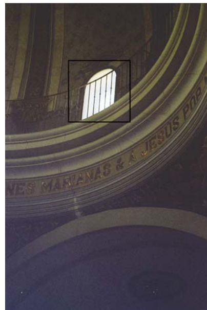
Fig. 34. Arco de ladrillo en ventana de la cúpula de la iglesia.
