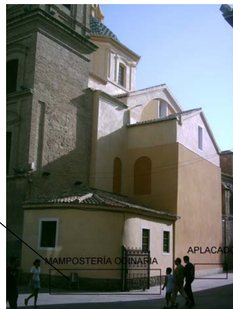
Fig. 23. Zócalos de piedra natural; de mampostería ordinaria y aplacado ejecutado como se aprecia en la figura 24:
