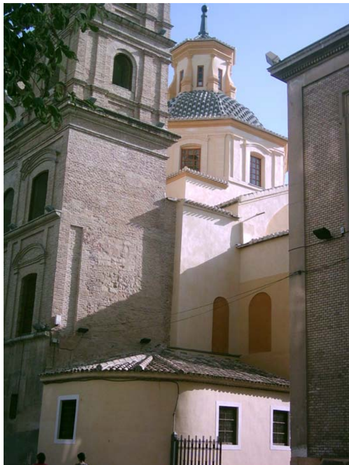
Fig.19. Los distintos tipos de enfoscado según acabados.
