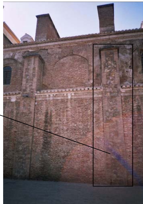
Fig. 20. Contrafuertes inferiores ejecutados de esta manera.
