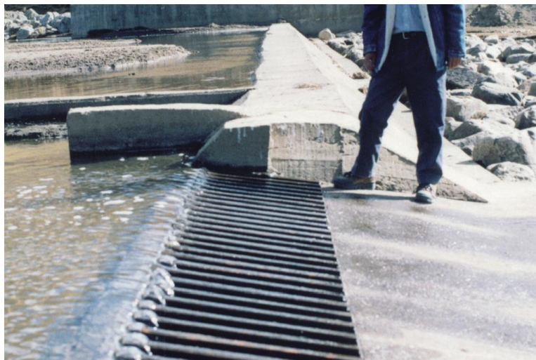
Figura 2. Toma de fondo de agua Tirolesa. (Fuente: PRONAR, 2010)
