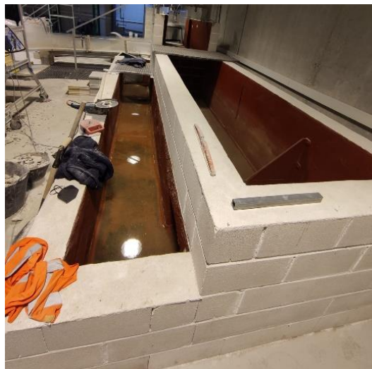
Figura 8. Canal de caudal no captado
