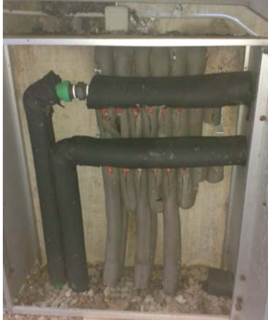
Figura 11. Colectores de pozos geotérmicos Figura 12. Tuberías de impulsión y retorno
