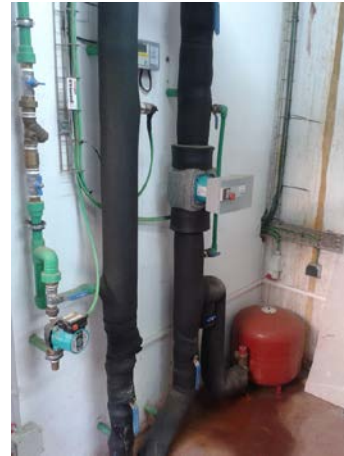
Figura 11. Colectores de pozos geotérmicos Figura 12. Tuberías de impulsión y retorno
