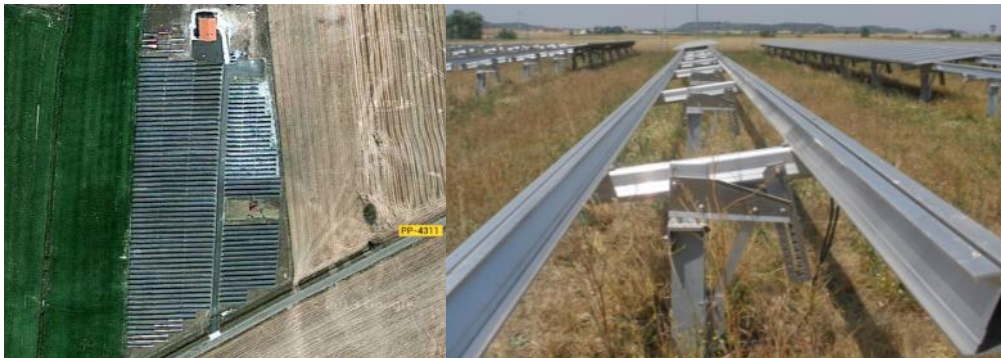
Figura 1: Instalación CIDESOL S.L.
