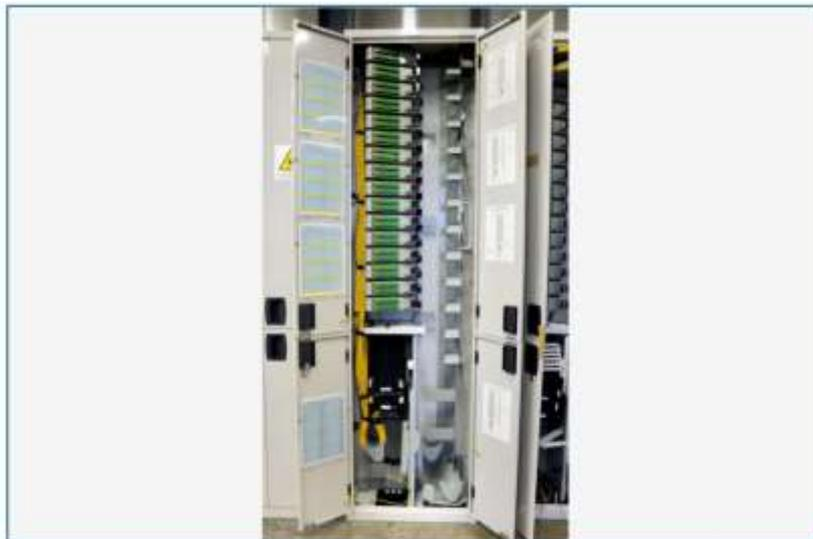
El Repartidor Óptico Modular permite terminar en conectores las fibras ópticas de los cables de alimentación o enlace y realizar la interconexión óptica fibra a fibra entre distintas redes o equipos.
