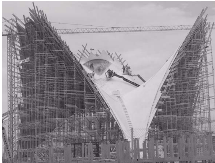
Figura 1. Lámina en construcción (Parque Oceanográfico Universal, Valencia)
