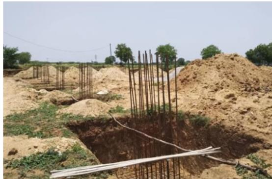
5. CIMENTACIÓN (RELLENAR DE CEMENTO) BASE PARA LA ESTRUCTURA. REALIZACIÓN DE ZAPATAS
