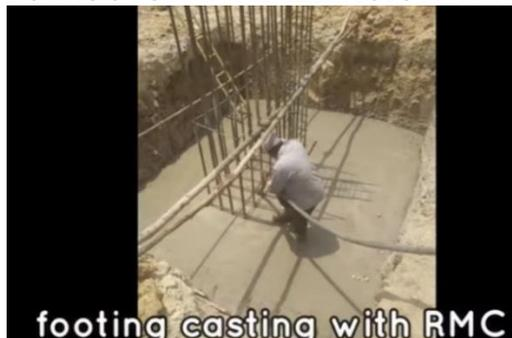
6. CONSTRUCCIÓN DE LOS PILARES DE HORMIGÓN SOBRE LAS ZAPATAS
