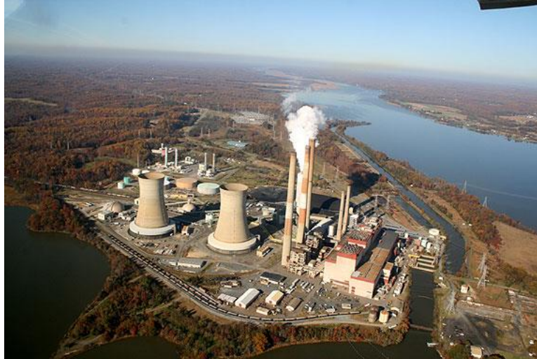
Figura 2.2. Vista aérea de la central eléctrica de Chalk Point. Fuente: Google Chrome .
