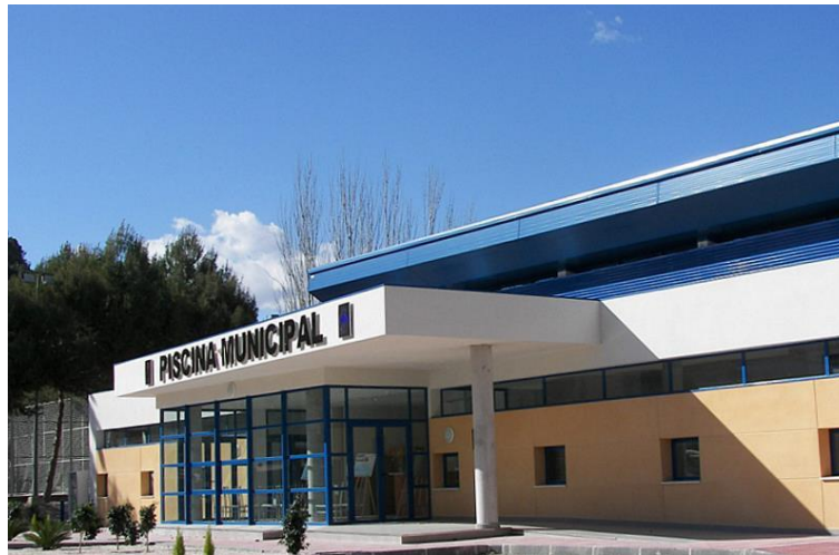
Figura 42. Imagen de la entrada principal de la Piscina Municipal de Archena
