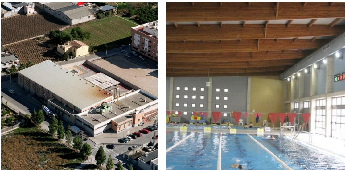
Figura 53. Imágenes exterior e interior de la piscina de Puente Tocinos, en Murcia
