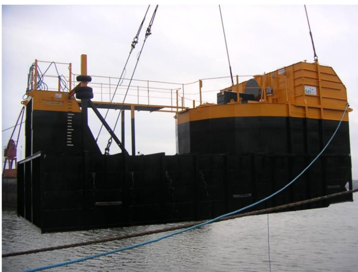
Figura 13. Sistema EO Buoy suspendido. Se pueden apreciar las bocas de entrada para el oleaje a la izquierda de la figura. Tomada de (Ocean Energy, s.f.)
