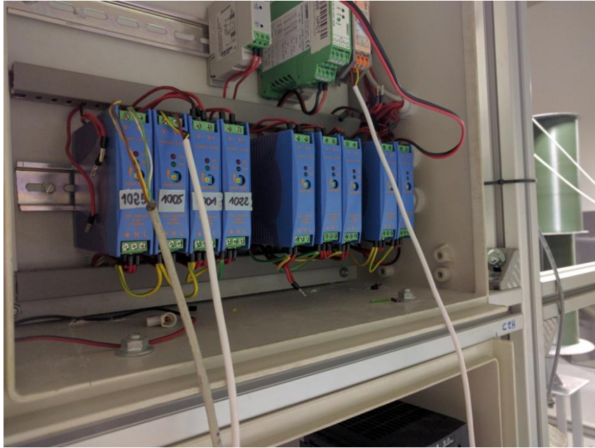
Figura 62: Fuentes de alimentación de 24 V. Se utilizan las dos de la izquierda
