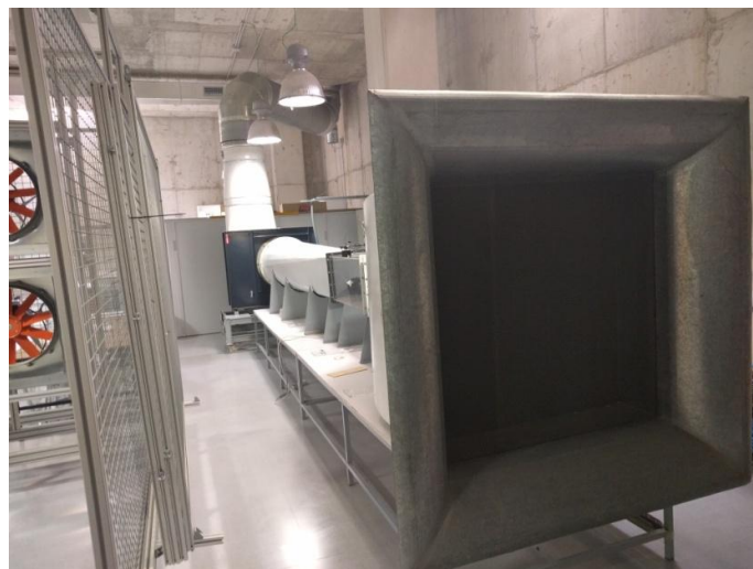
Figura 64: Túnel de viento del laboratorio de ensayos
