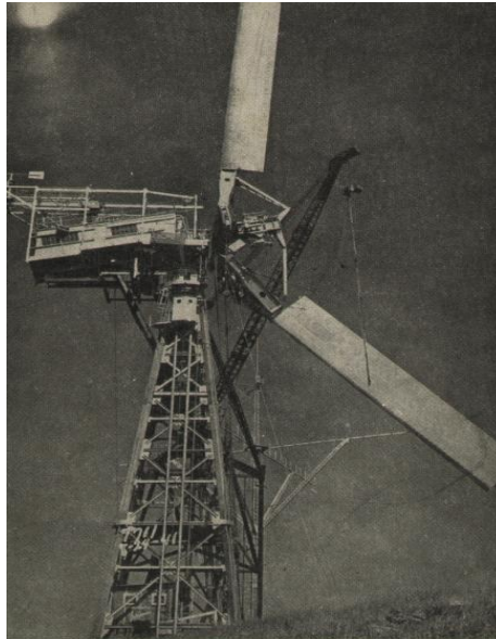
Figura 1: Aerogenerador Smith-Putnam (años 40). Diseño de gran complejidad y audacia y que por problemas de fatiga de material sufrió graves fallos.
