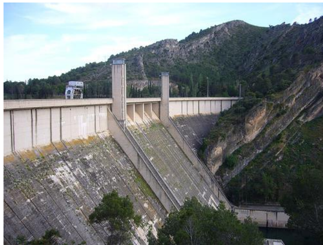
Figura 5.1 Presa de Buendía.
