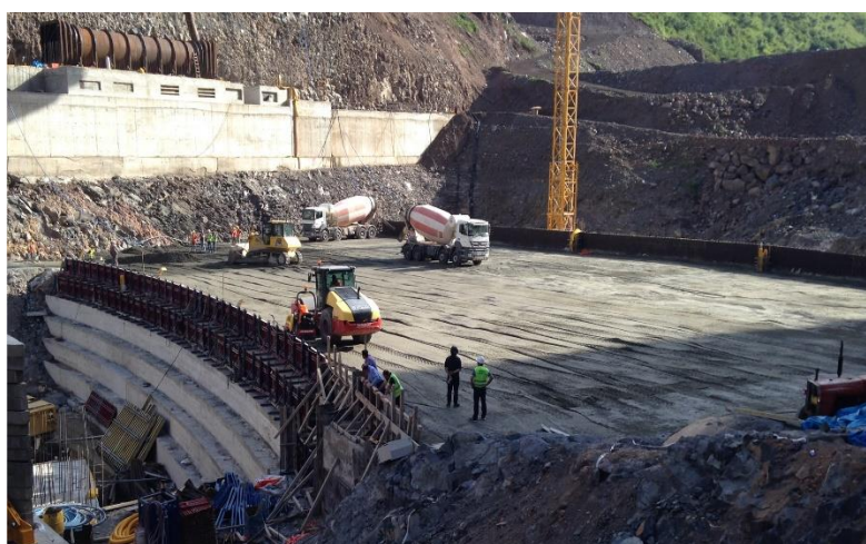
Figura 2.8 Presa RCC Kotanli en construcción en Turquía. (Fuente: ARQ consulting engineers)
