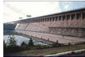
Ilustración 4. Presa de Bratsk
