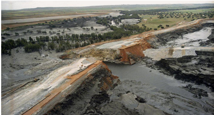
Ilustración 6. Balsa de Aznalcóllar 16 años después del accidente.
