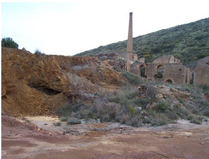
Ilustración 5. Chimenea en la Rambla del Avenque. Fuente: Fundación Sierra Minera. Centro de Interpretación de la mina Las Matildes (2007); recuperado de http://www.fundacionsierraminera.org/
