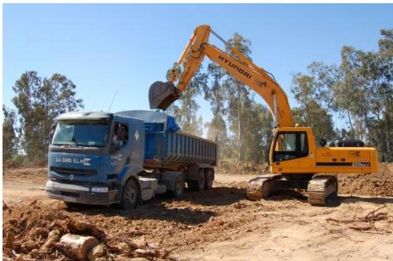
Una vez realizado el replanteo de la cimentación, se procederá a la excavación de esta, que se realizará con medios mecánicos, y perfilado a mano, dejando el terreno preparado para posteriormente realizar la cimentación por pilotes.
