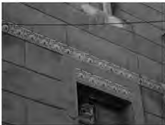
Fig. 6: ejemplo de fingido de silleria
