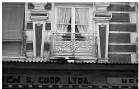
Fig. 5: Ejemplo de fingido a dos colores
