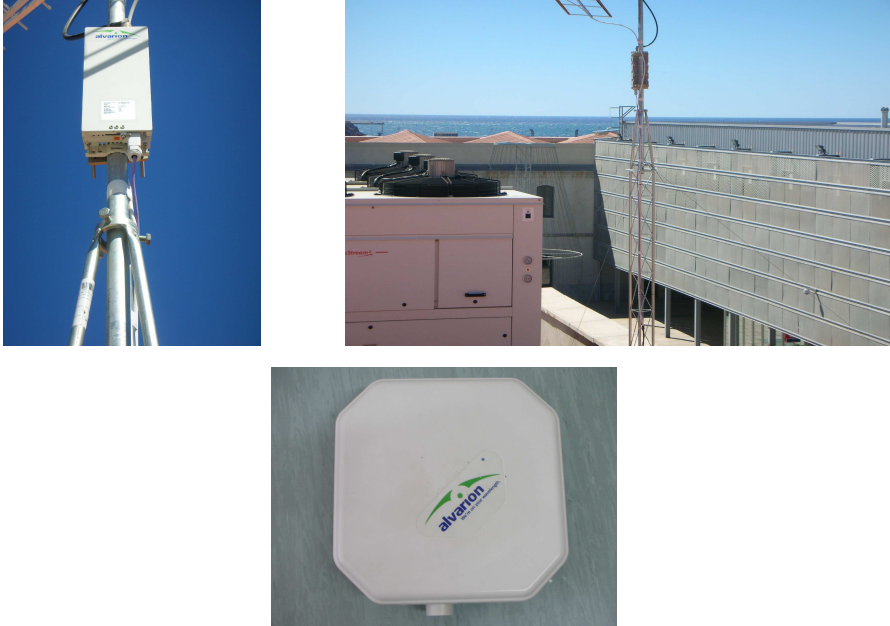
Figura 2: Detalles del hardware utilizado en la red de pruebas. Superior-izquierda: Estación base utilizada. Superior-derecha: Escenario utilizado para el despliegue. Inferior: Detalles de la antena cliente WiMAX.
