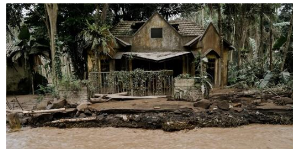
Figura 2.1. Viviendas afectadas por riadas
