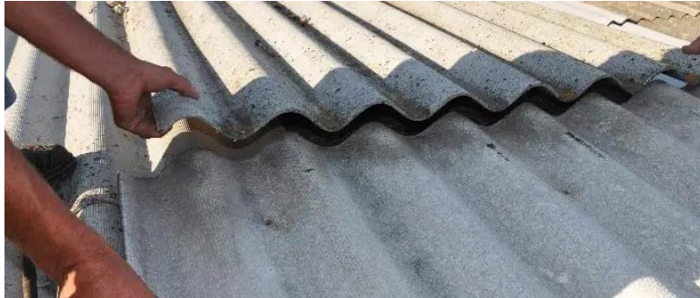
Ilustración 4. Fibrocemento en buen estado. Material no friable. Fuente: Petty, L. (2016).
