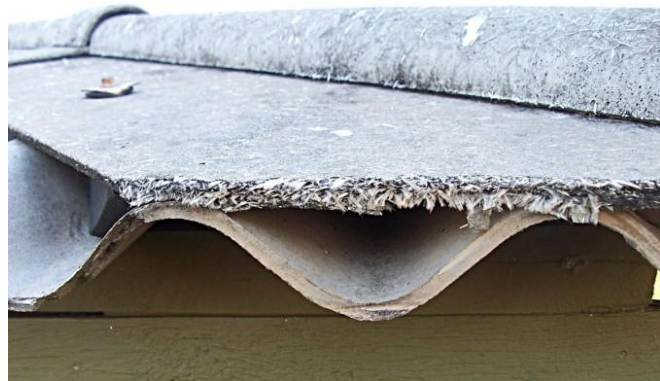
Ilustración 3. Fibrocemento deteriorado. Material friable. Fuente: Landry and Swarr. Louisiana's asbestos attorney. (2015).
